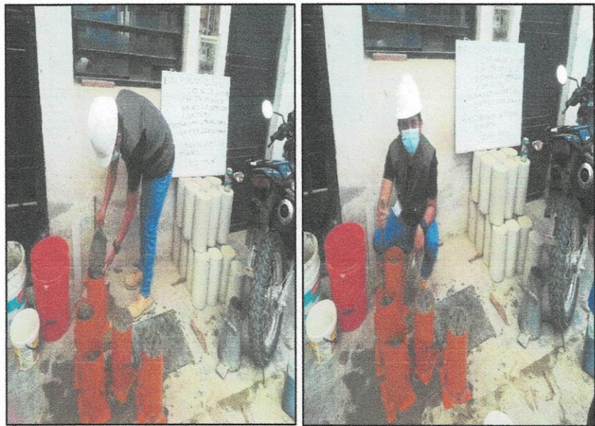
Fotografía N° 21 y 22. Llenado de moldes de probetas para cada diseño de mezcla y chuseado correspondiente para posteriormente someterlos a los ensayos de compresión.
