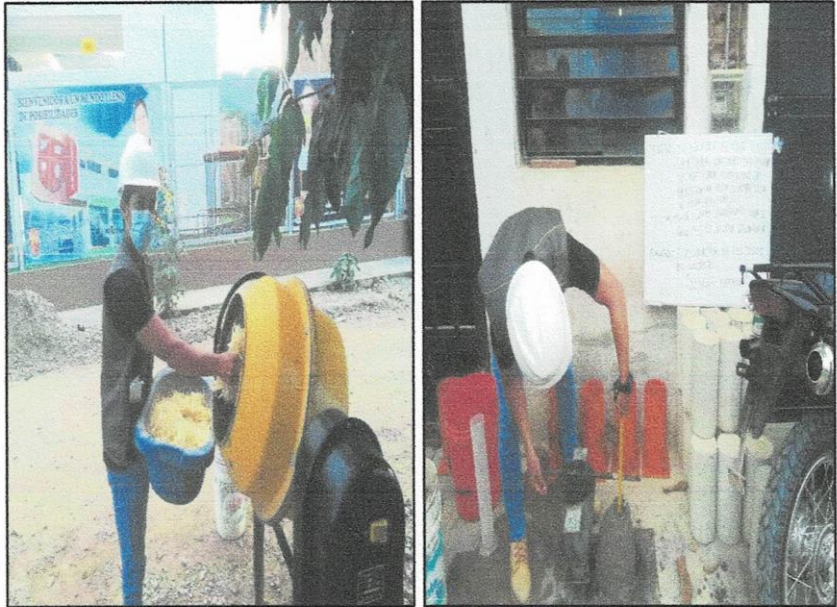
Fotografía N° 19 y 20. Incorporación de la FNPA (fibra natural de pluma de ave) al concreto, y medición del SLUMP en cada diseño realizado.
