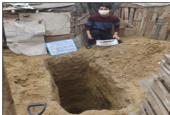
Figura 3. Excavación a 3.00 m.
