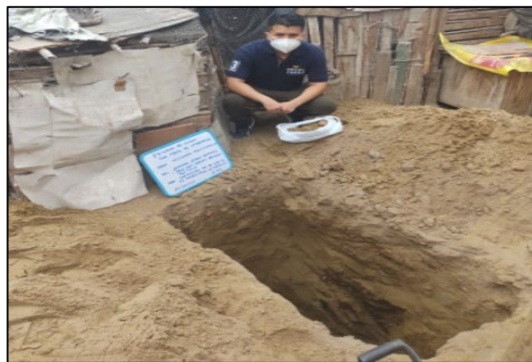
Figura 2. Excavación a 0.55 m.
