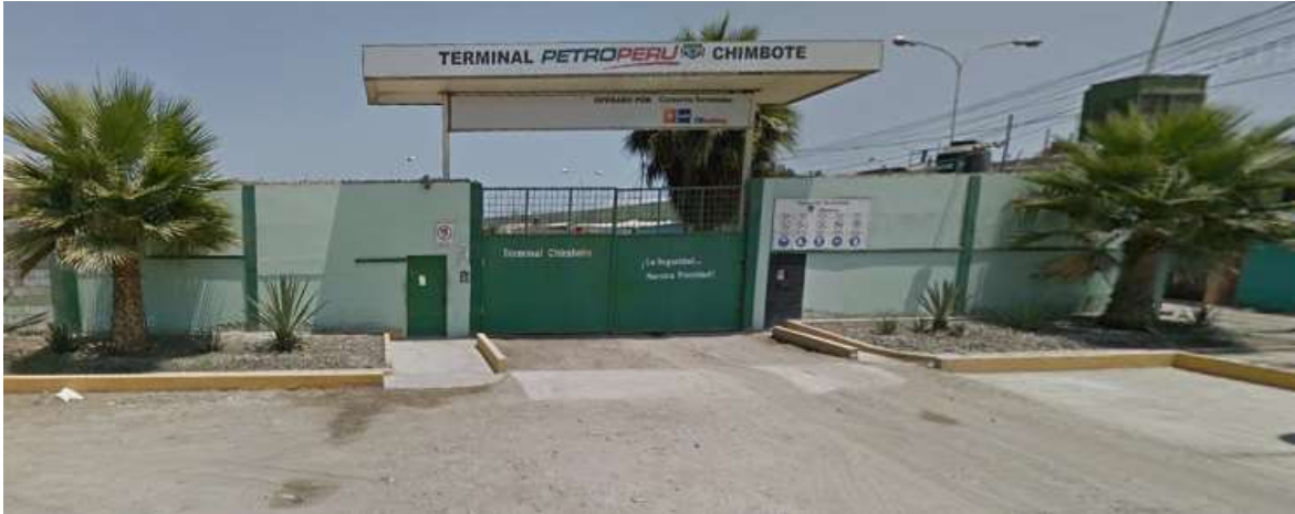
Figura 31: Puerta principal, de acceso a la Planta
