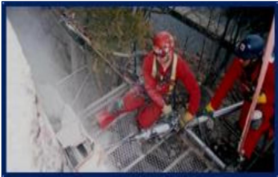
Figura 15: colocación de pernos en la roca
