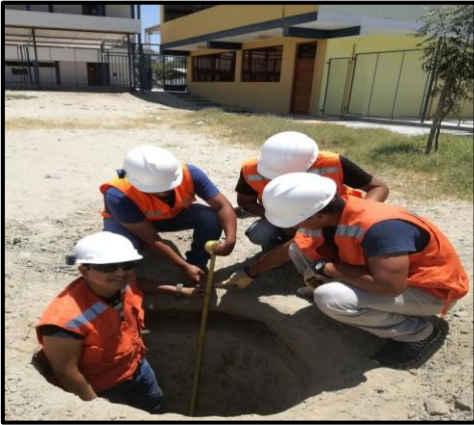
Foto N° 01. Excavación de calicatas
