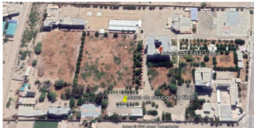
Figura 4. Vista Satelital de Playa de Estacionamiento
