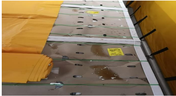
Figura 33. Techo de los pallets con agua y orificios descubiertos
