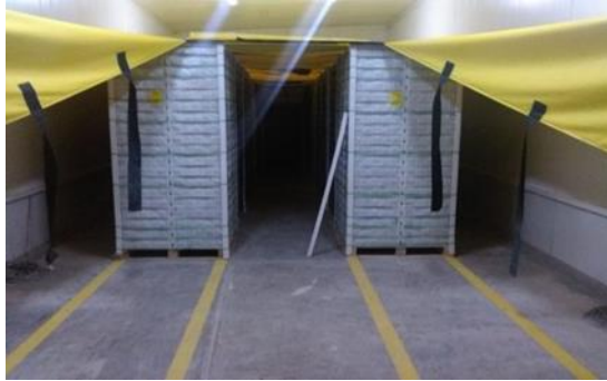
figura 18. túnel con pallets en inversión de flujo de aire
