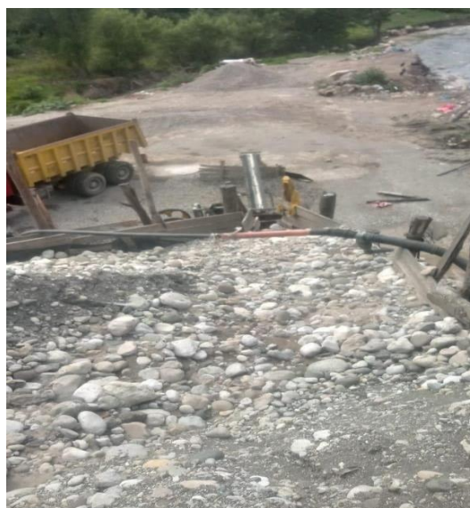
Figura 03: Vista del abastecimiento de piedras hacia la máquina chancadora
