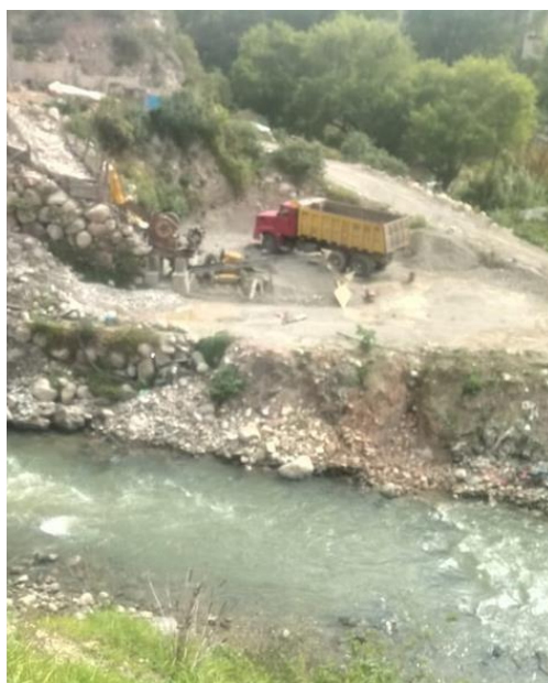
Figura 05: Carga de material a volquete
