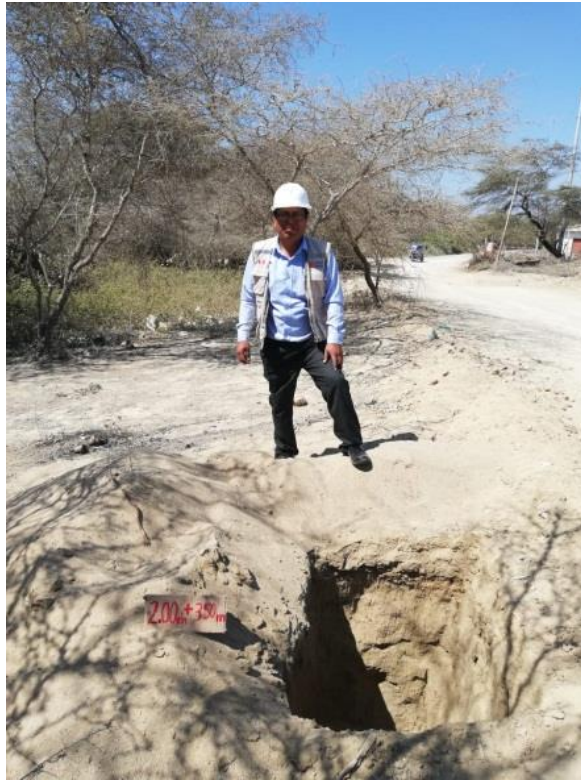
Figura : Calicata N° 3 con progresiva 2.0 + 350m.
