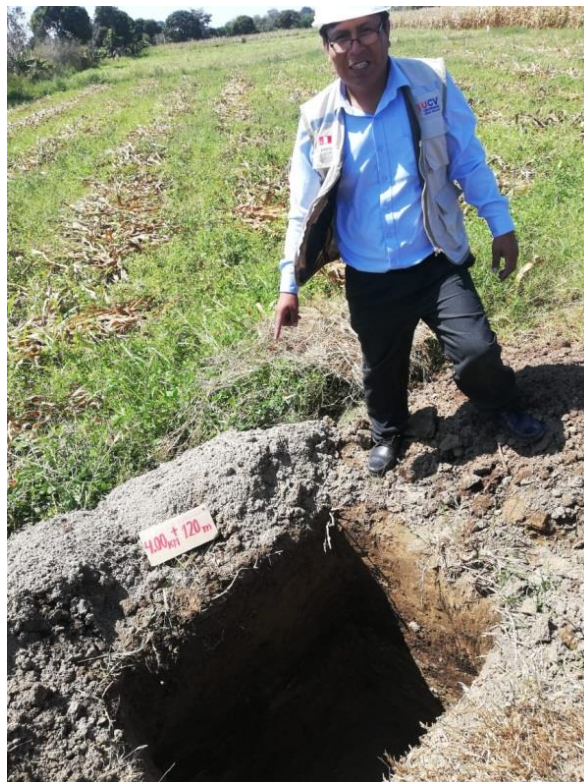
Figura : Calicata N° 4 con progresiva 5.0 + 050 m.
