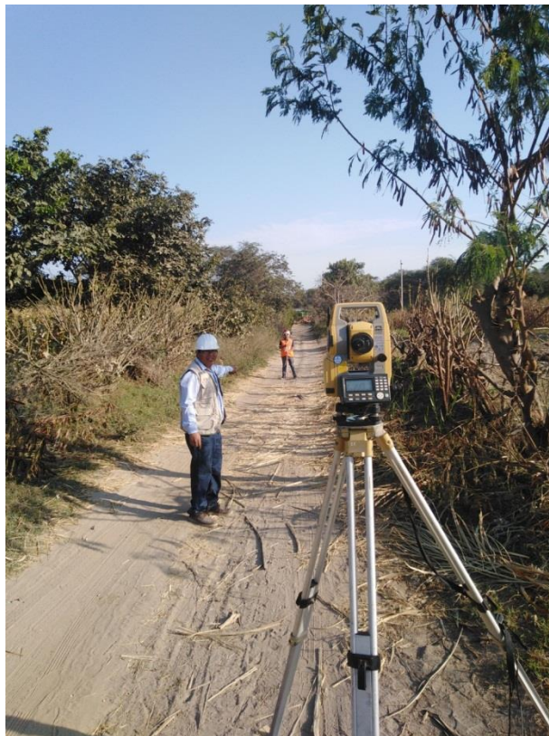
Imagen 04. Levantamiento planimétrico en camino vecinal Annape – Carrizal
