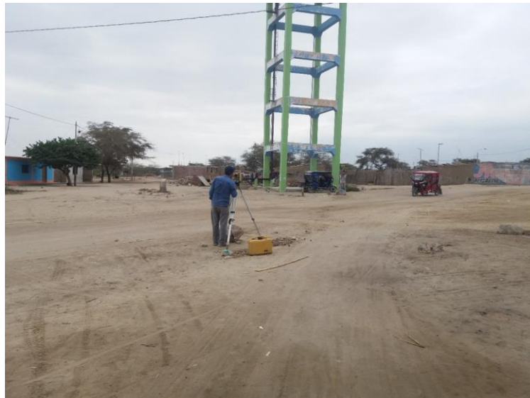
Imagen 10. Tanque elevado –Caserío Annape
