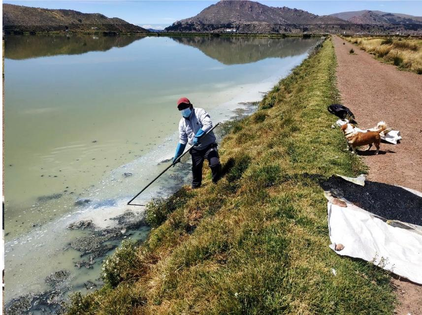
**Fotografía N 01:** extracción de lodo de la planta de tratamiento de aguas residuales (laguna de oxidación Espinar – Puno)
