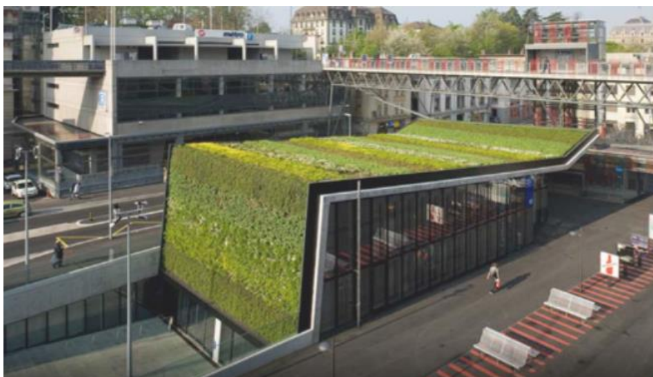
Figura 92. Estación de Metro Flon / Suiza, 2008 por Bernard Tschumi Architects.
