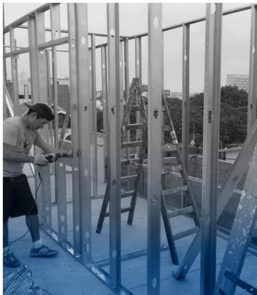
Figura 102. Instalación – Sistema Drywall Fuente: CAPECO
