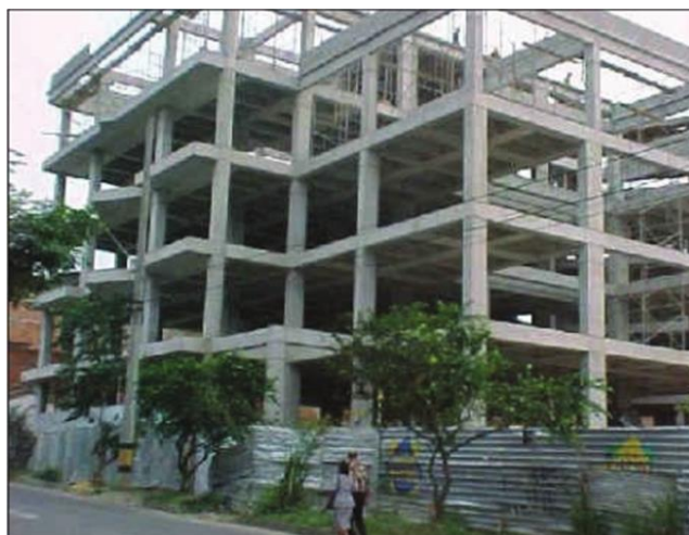
Figura 100. Edificio construido - sistema aporticado Fuente: Escuela de Ingeniería de Antioquía, Análisis de Estructuras I
