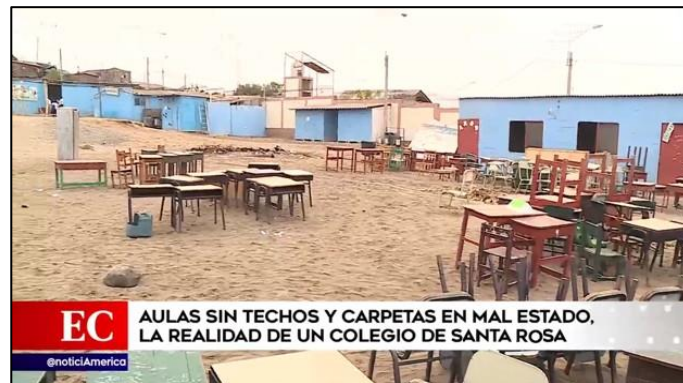
Figura 12. Mal estado de los colegios
