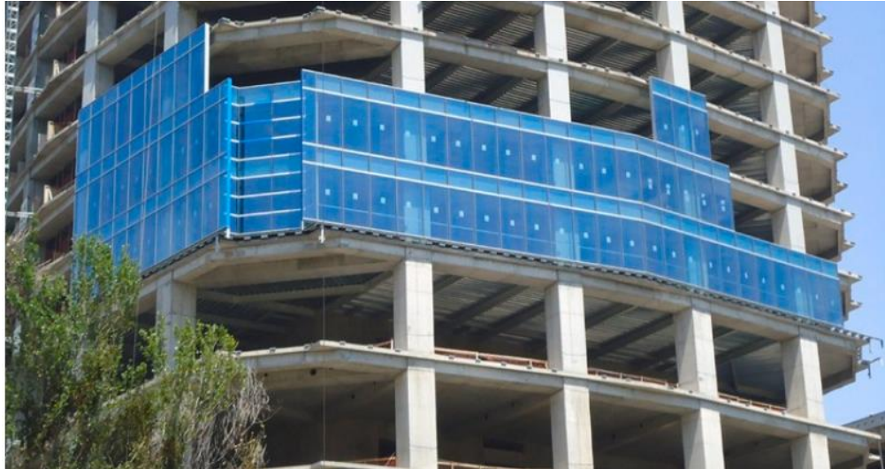
Figura 105. Instalación – Muro Cortina Fuente: ArchDaily
