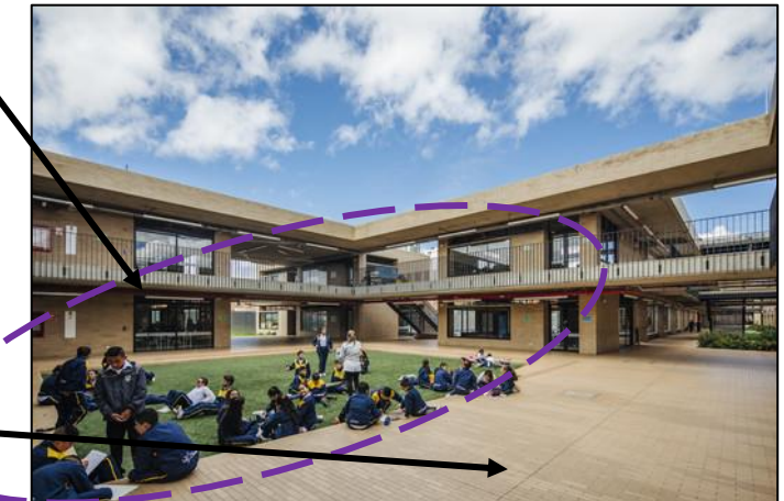
Aula de talleres con Alturas libres.
