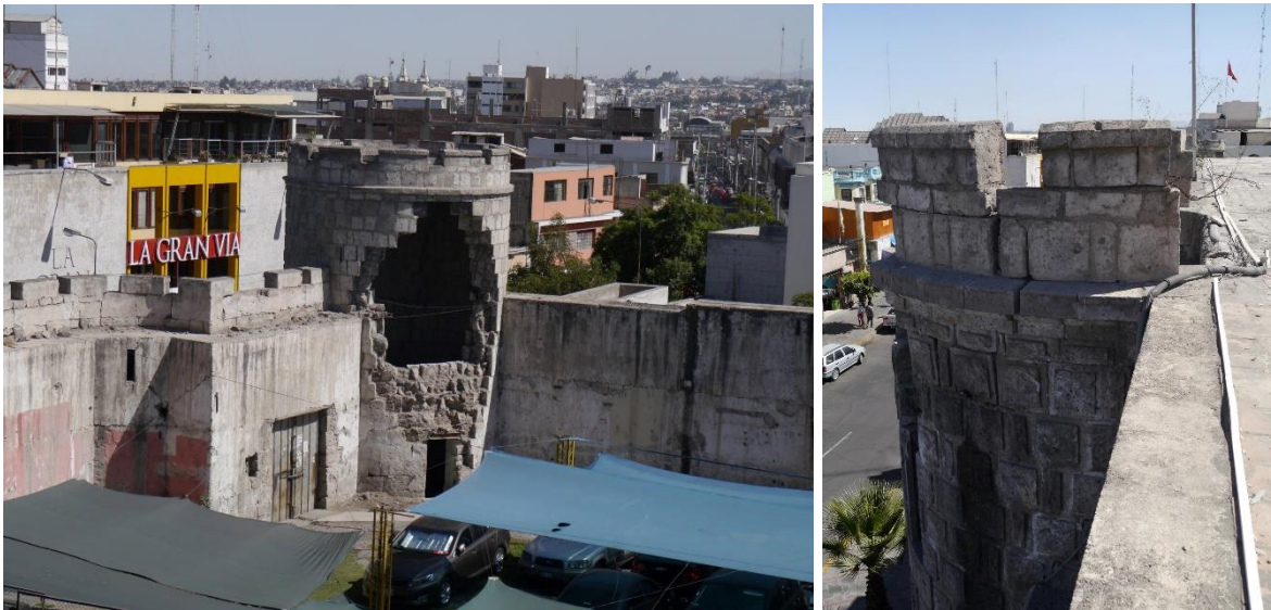
Figura 4: Estado actual de la muralla, Ex cárcel siglo XX
