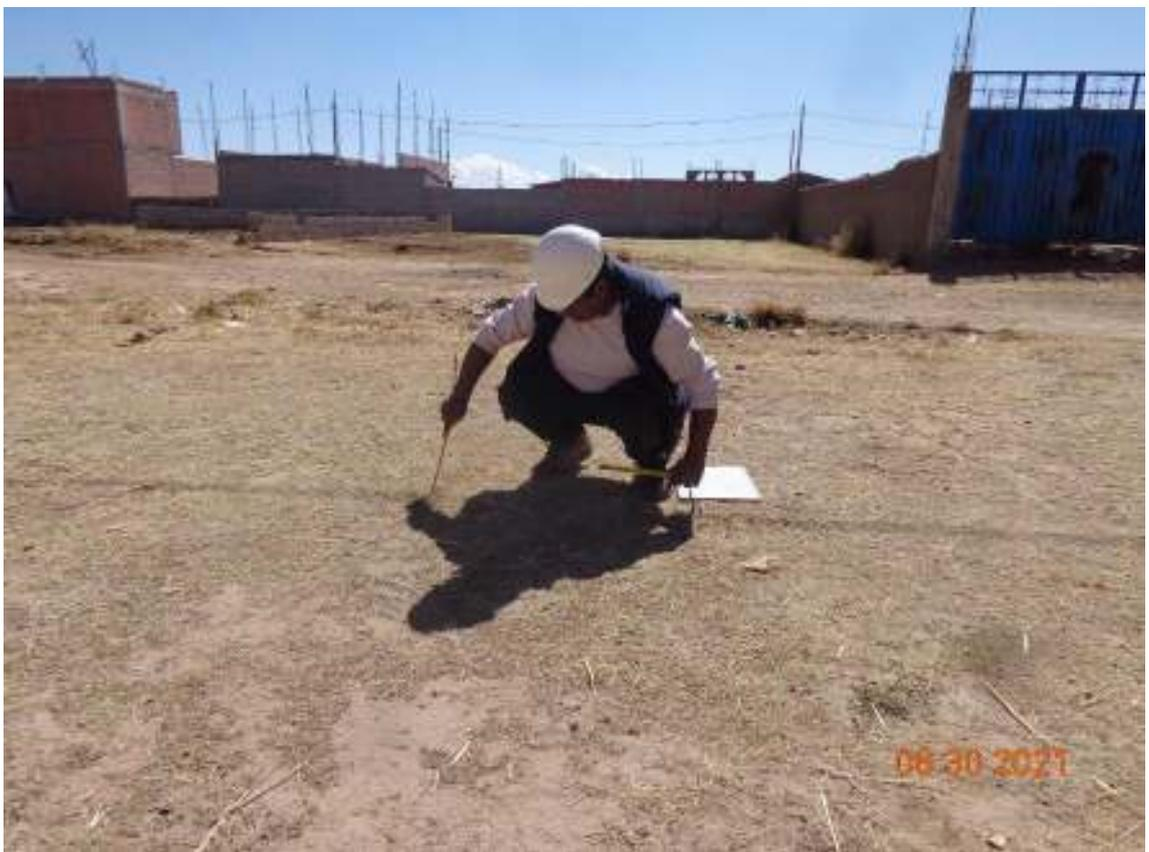
Fotografía N° 07, demarcación de del terreno para excavación de calicata.
