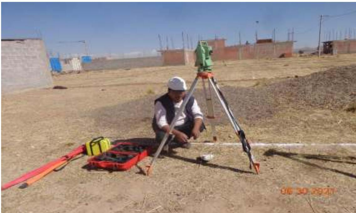
Fotografía N° 01, Colocación de BM y estacionamiento de la estación total.
