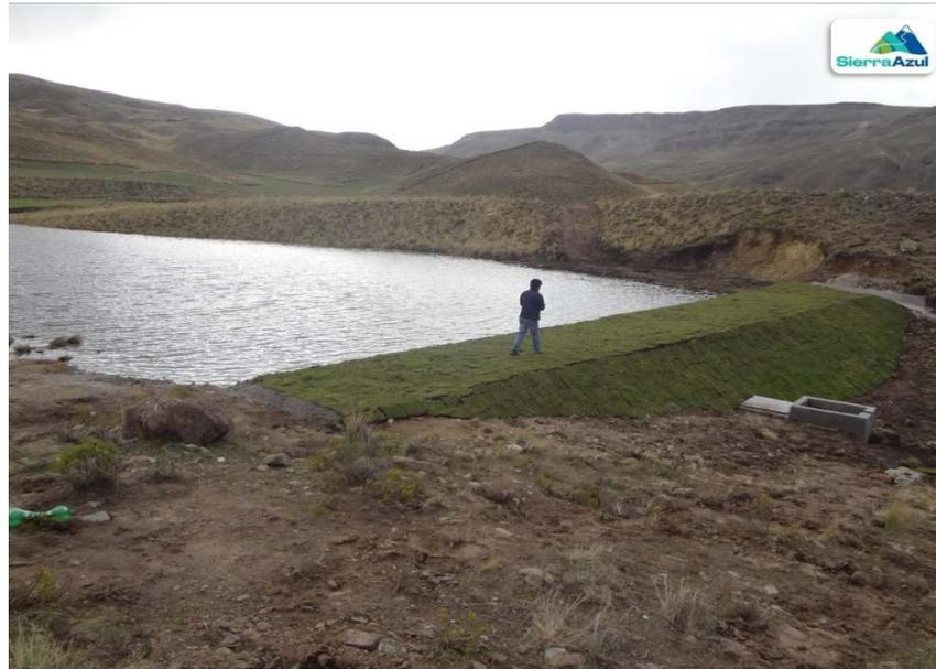
*Figura N° 9: incremento de Capacidad de almacenamiento de una Qocha de Infiltración*
