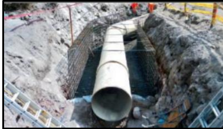
Figura 5. Construcción de línea de conducción
