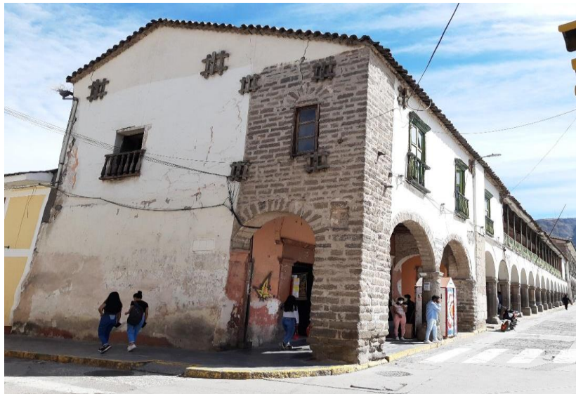
Vista fotográfica de la Casona Diego Ladrón de Guevara
