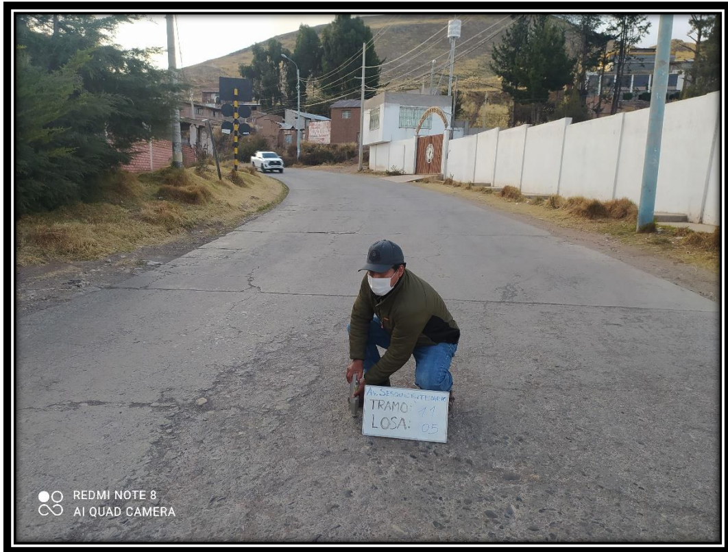
Figura. Ensayo con esclerómetro
