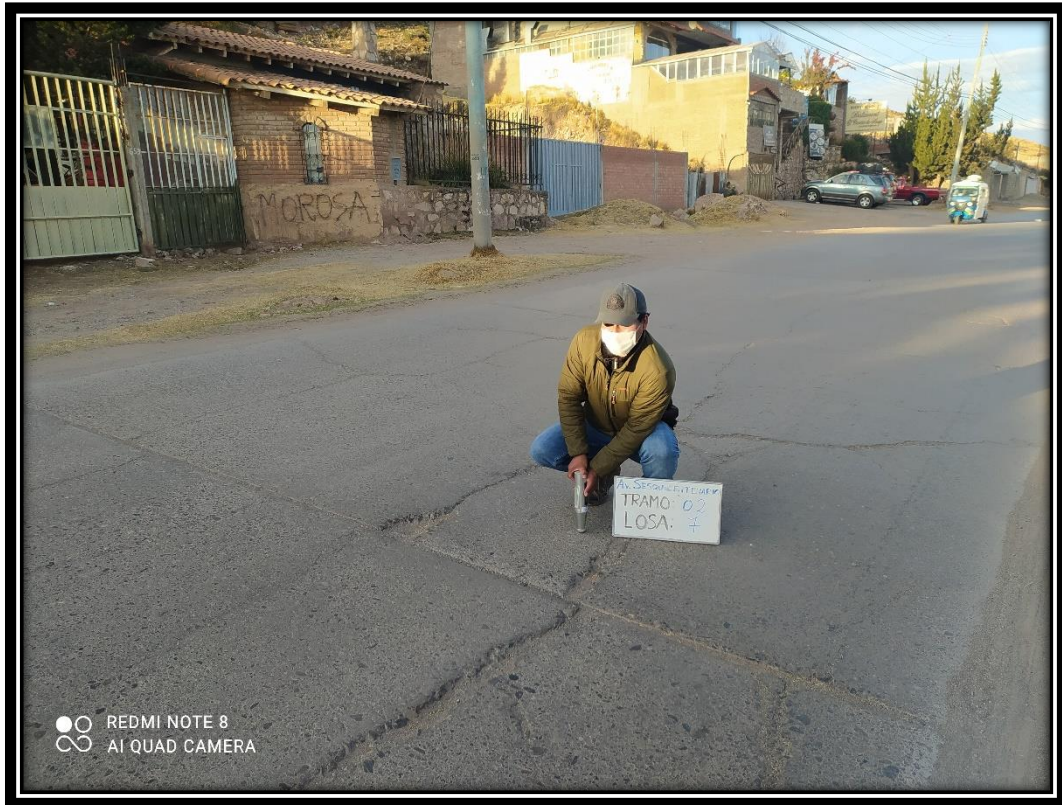
Figura. Ensayo con esclerómetro
