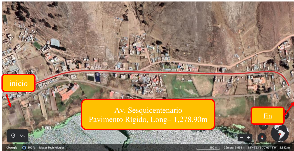
Figura. 35 Avenida sesquicentenario tramo pavimento rígido
