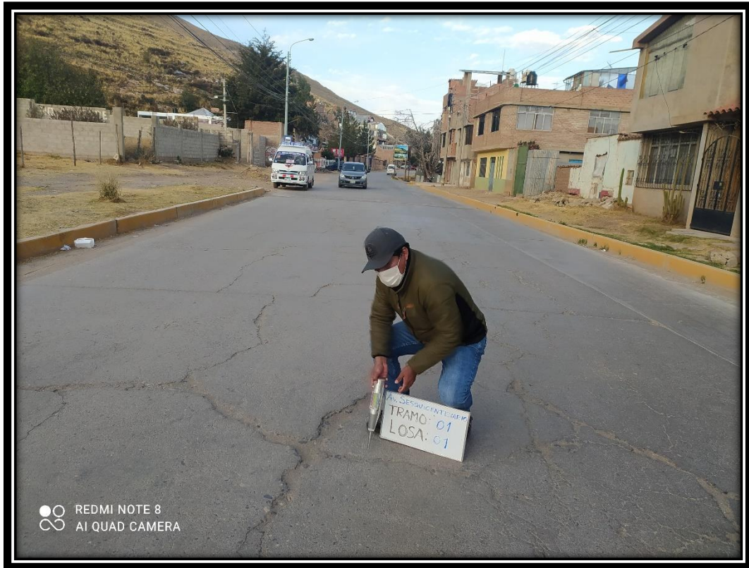
Figura. Ensayo con esclerómetro
