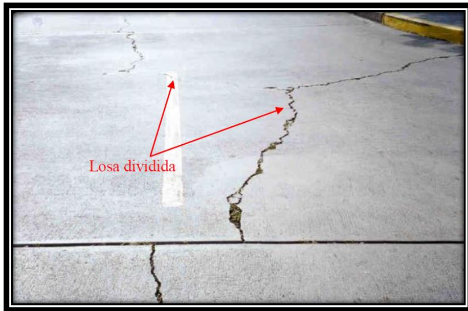
Figura. 10 Losa dividida
