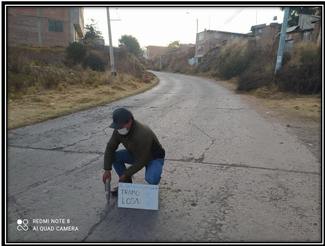
Figura. fotografía ensayo con esclerómetro
