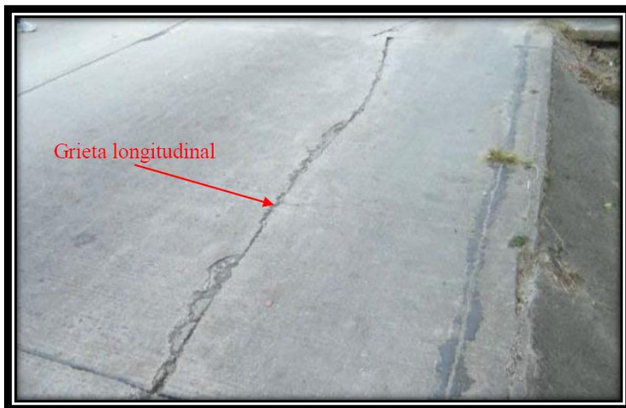
Figura. 15 Grieta longitudinal
