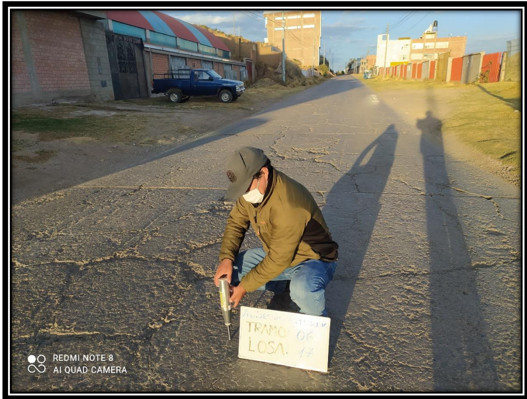
Figura. Ensayo con esclerómetro
