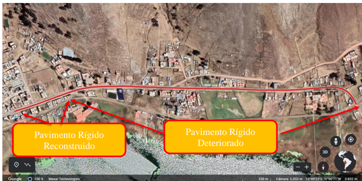
Figura. 36 Avenida sesquicentenario pavimento rígido reconstruido y deteriorado
