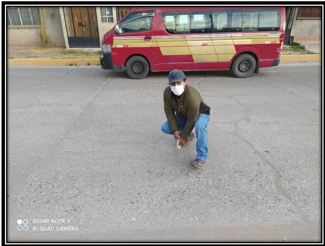
Figura. fotografía ensayo con esclerómetro
