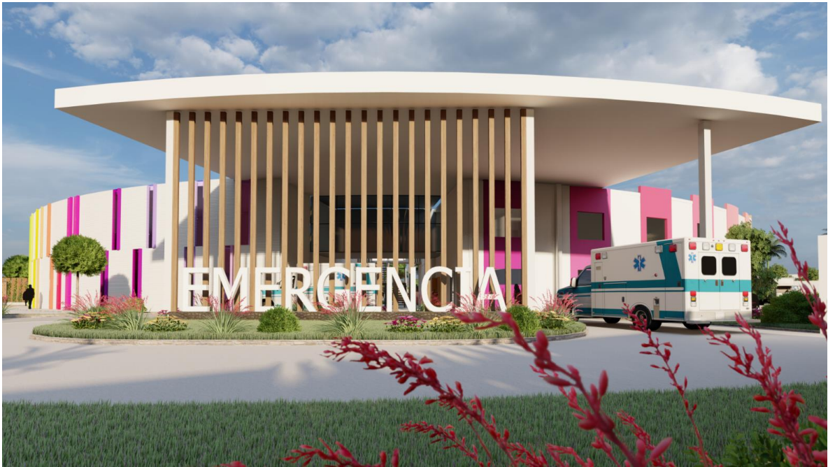
Ingreso vehicular y peatonal a la Unidad de Emergencia
