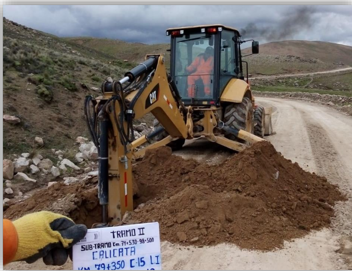
Figura 16: Obtención de muestras de las calicatas.
