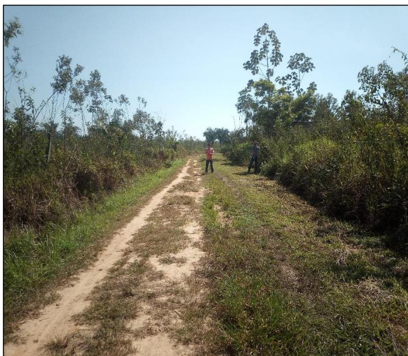
Foto N°02: Se observa plataforma sin capa de rodadura a partir de la progresiva 03+000 hasta 08+811
