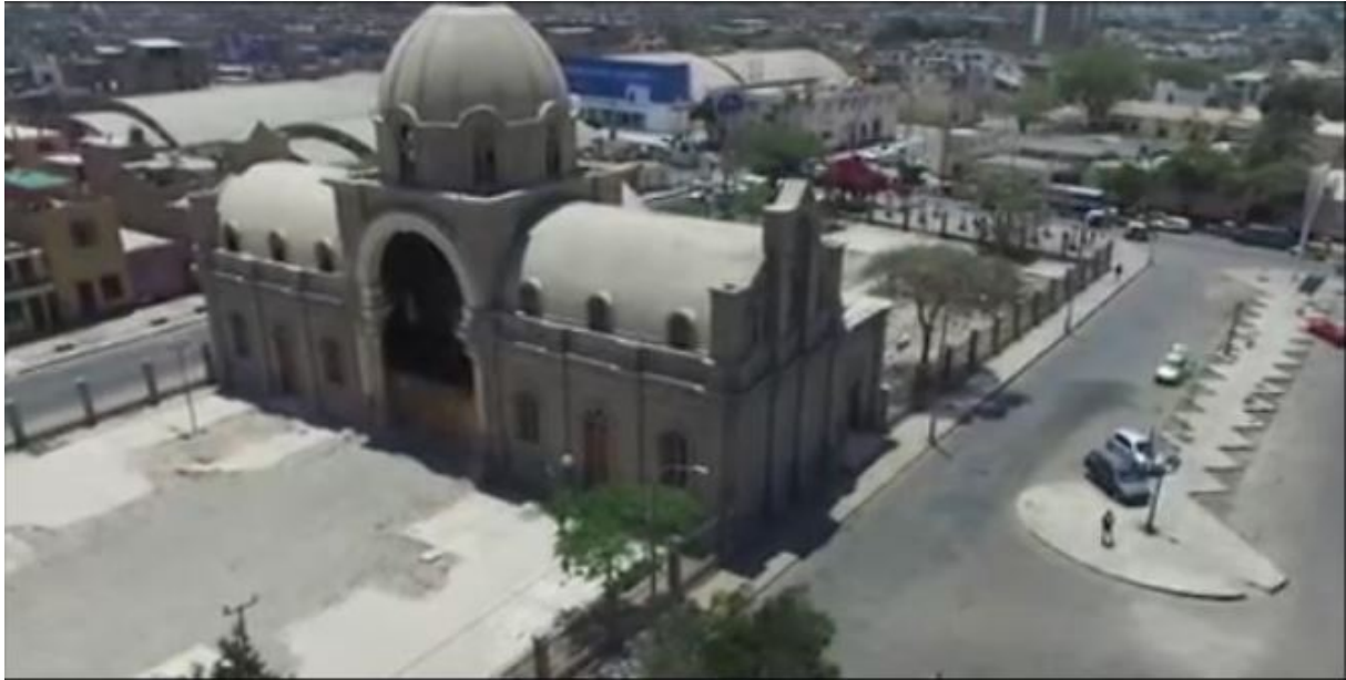
Figura 4.8: Foto aérea de lo que queda en pie del Santuario de Luren: el Transepto y el Ábside
