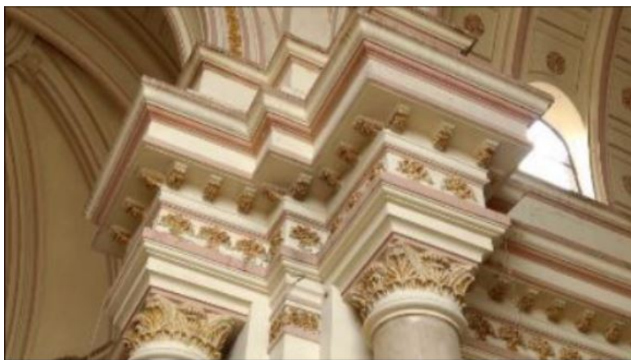
Figura 4.4: Detalle de las molduras que se entrecruzan en los capiteles de las columnas que sostienen el tambor de la cúpula. Estas piezas serán cortadas y retiradas (Stacco) en piezas para su réplica.
