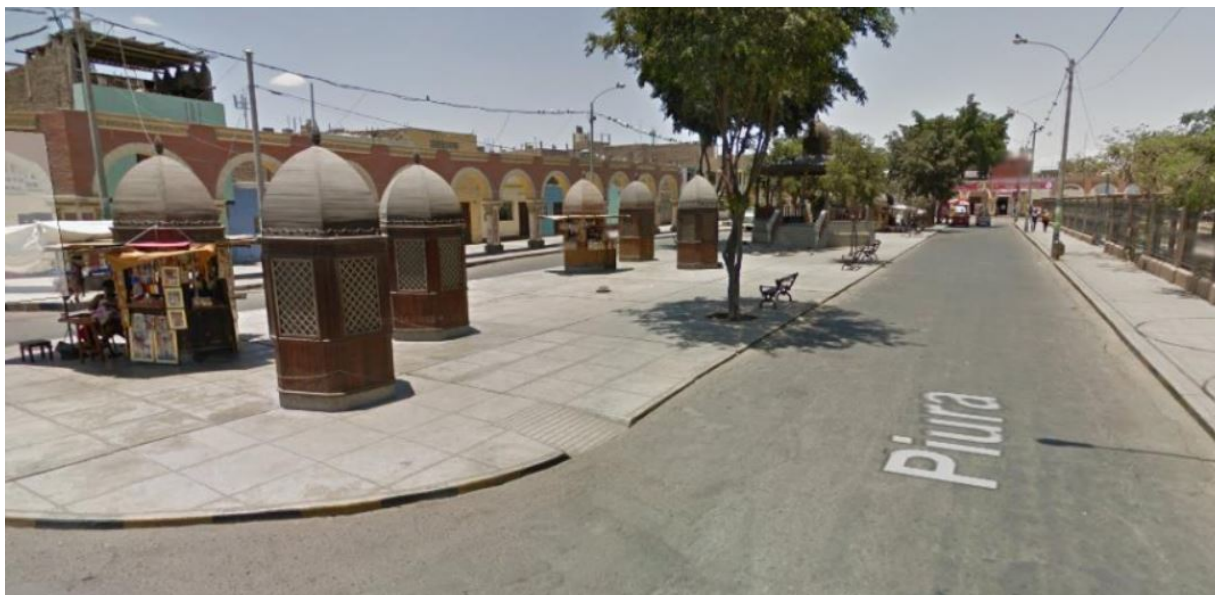
Figura 4.15: Vista de los pavimentos y carpeta asfáltica existente
