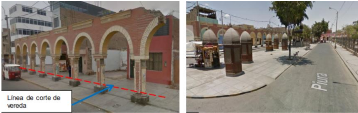
Figura 4.16: Vista de veredas a demoler
