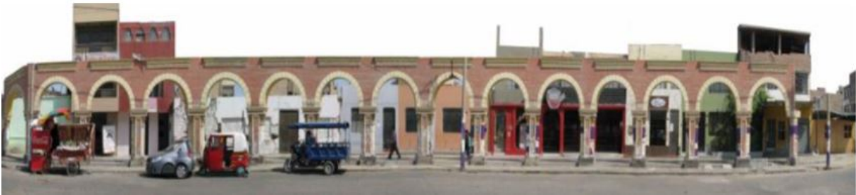
Figura 4.13: Vista de la fachada de la arquería en la calle Ayacucho, en la calle Piura y en la calle Nasca
