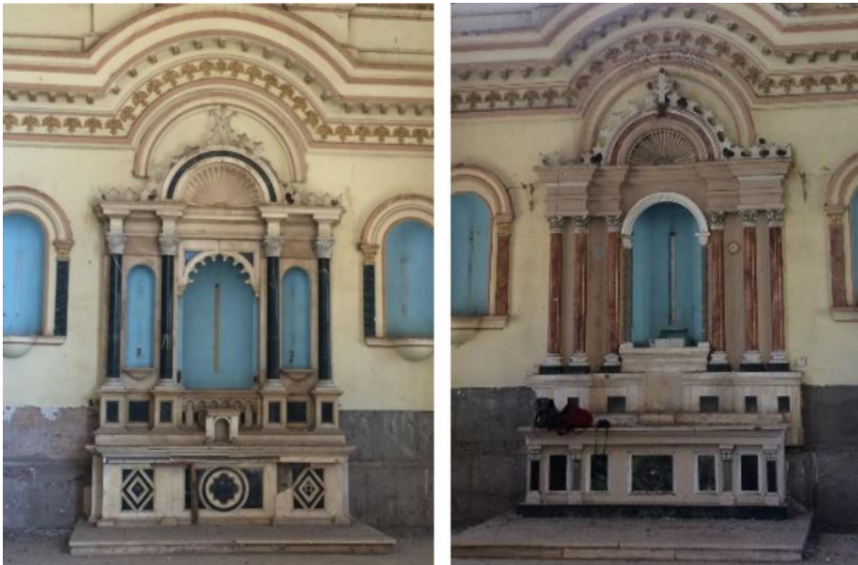
Figura 4.7: Retablo del muro de la Epístola (01) que quedará in situ previo desmontaje de algunos elementos sueltos (imagen de la izquierda). Cuenta con columnas de mármol. Retablo muro del Evangelio (02) el cual será aplantillado, desmontado para ser reconstruido con las mismas características (imagen de la derecha)
