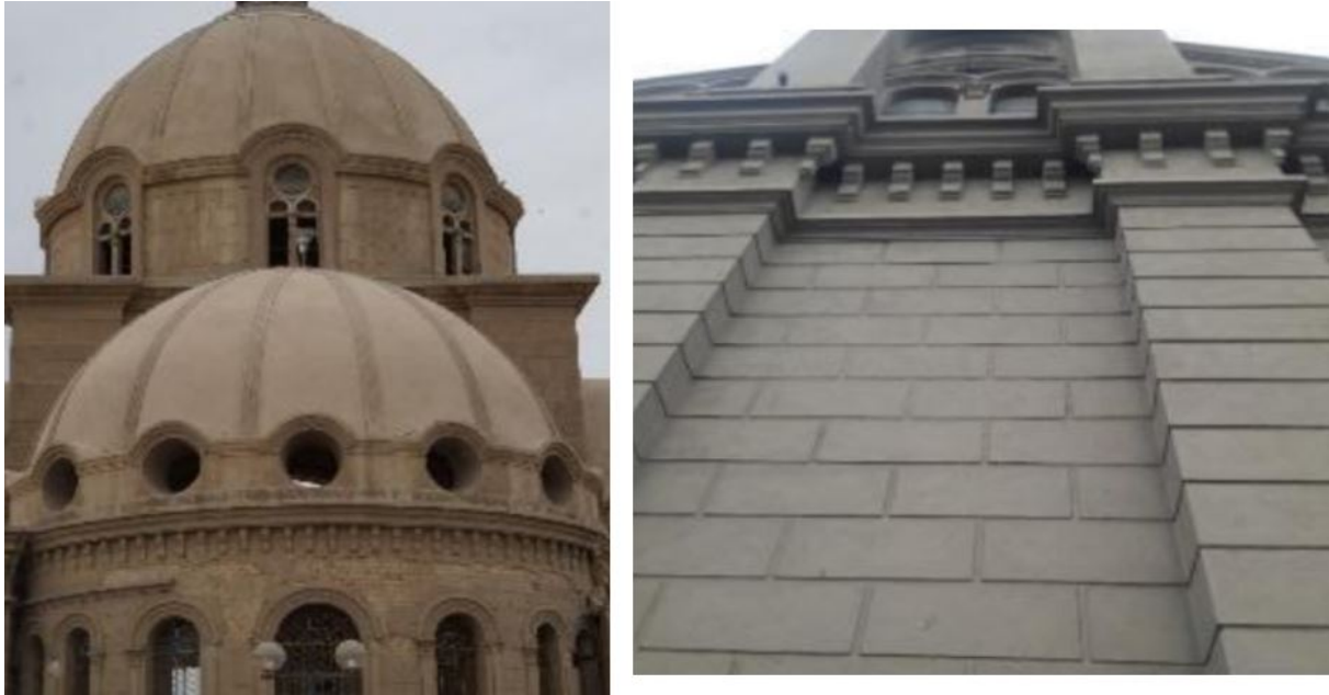
Figura 4.6: Vista del exterior del transepto, y los detalles a aplantillamy modillones a retirar para el latex desmontante
