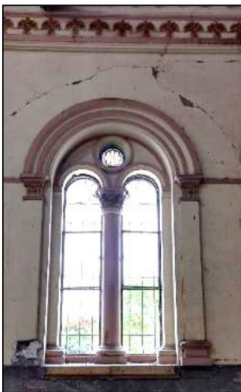
Figura 4.3: Vista de la ventana con parteluz que serán codificadas y desmontada en partes para su reposición. Nótese capiteles de los pilares que flanquean las ventanas que también serán desmontados para su reposición
