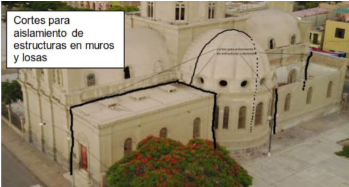
Figura 4.18: Esquema 1 de demolición
