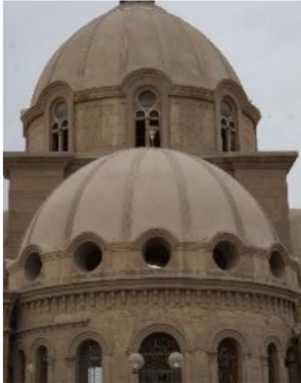
Figura 4.10: Fachada posterior del transepto
