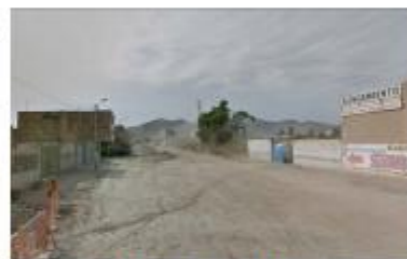
03 AV. SAN DIEGO DE ALCALA (Via Irregular, no cuenta con diseño de seccion vial, paraderos, deficit de ciclovía, deficit de camellones de paso peatonal).
