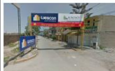
02 JR. SANTA TERESITA DE N. J. (Vía inconclusa, no tiene continuidad, ademas no cuenta con diseño de seccion vial)
