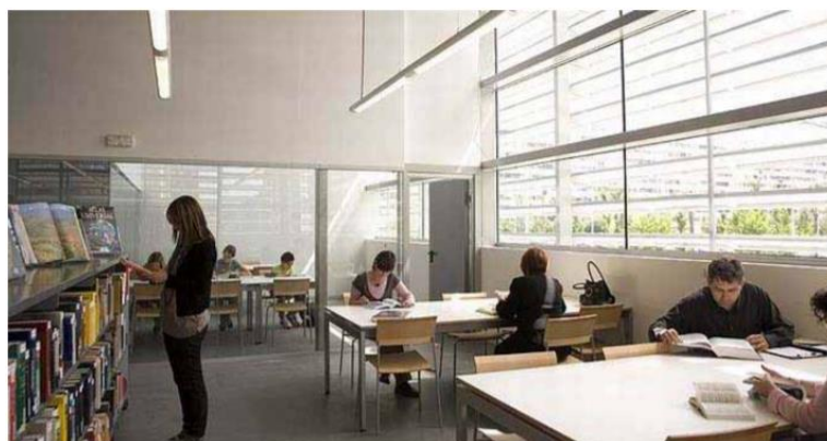
Figura 23: El vidrio como piel del edificio que permite maximizar el aprovechamiento de la luz. Fuente: (Bonet, I. y Sabater, I., 2010)
