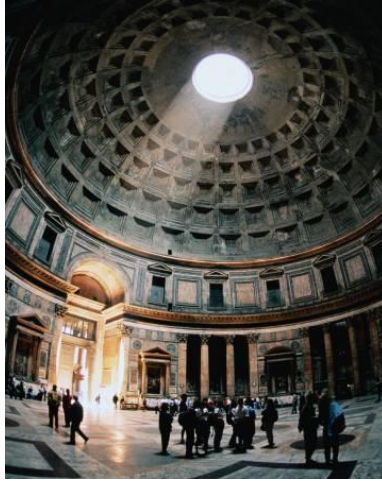
Figura 38: Cúpula y ojo de buey del Panteón de Roma, de nueve metros de diámetro. GETTY IMAGES
