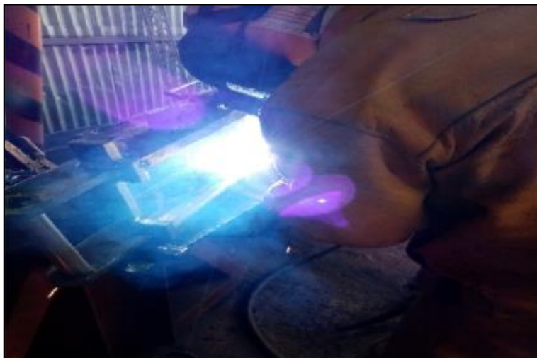
Foto 10. Área de Soldadura 1
