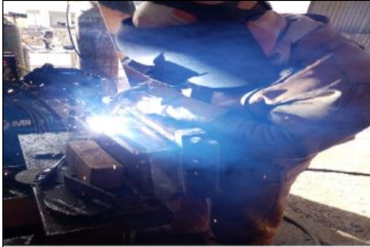
Foto 11. Área de Soldadura 2
