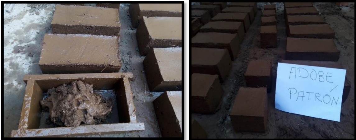
Figura 14. Elaboración de adobes
