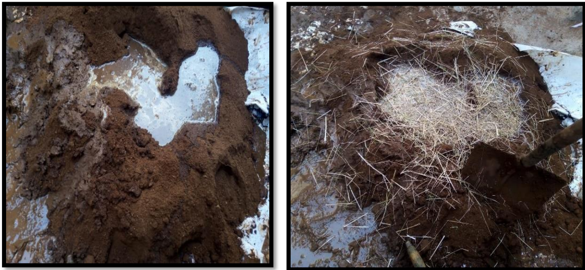
Figura 13. Mezcla de suelo para la elaboración de adobes
