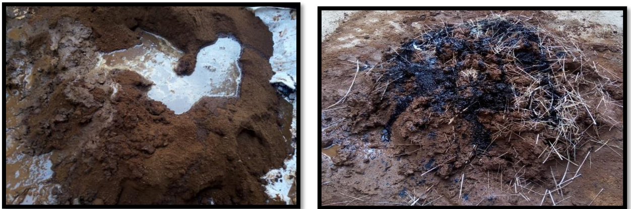
Figura 15. Mezcla añadiendo emulsión asfáltica
