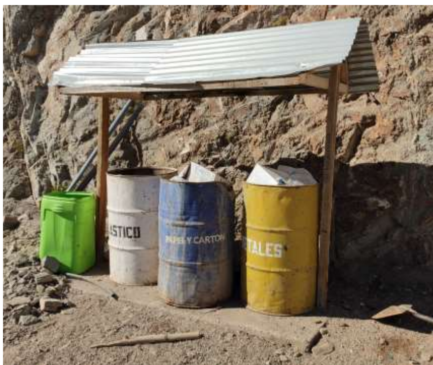
Figura 8: Mala segregación en el punto de acopio de RR.SS. y acopio sin estandarizar – enero 2020
