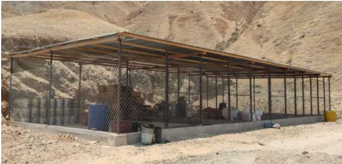
Figura 13: Almacén de residuos reciclables y peligrosos – enero 2021
