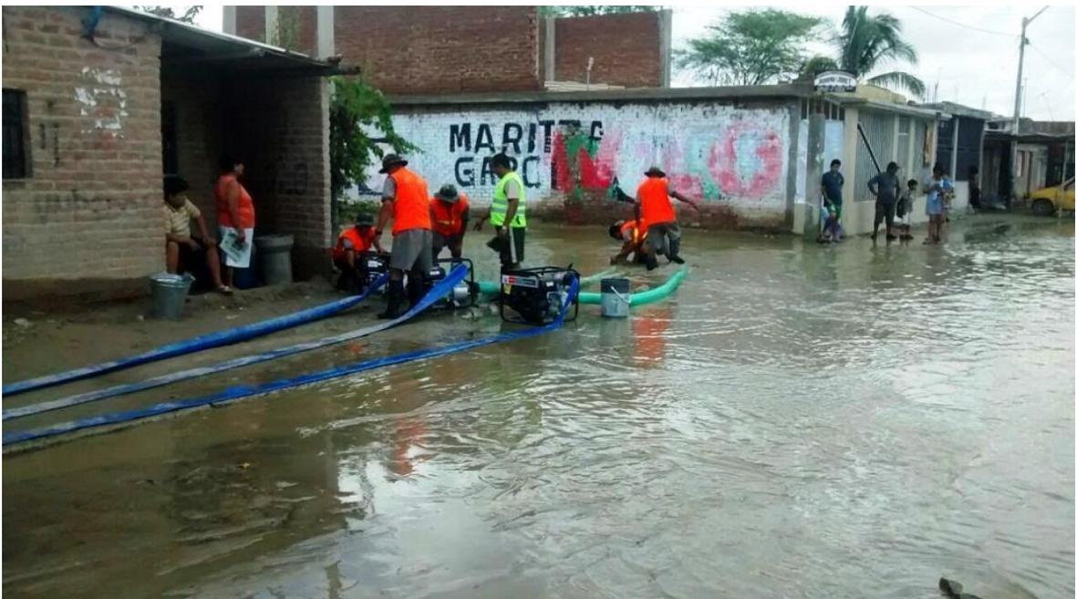
**Figura 13.** Evacuación de aguas pluviales, mediante motobombas, por falta de drenaje en los diferentes sectores del distrito de Castilla 2017. Fuente: Walac Noticias.
