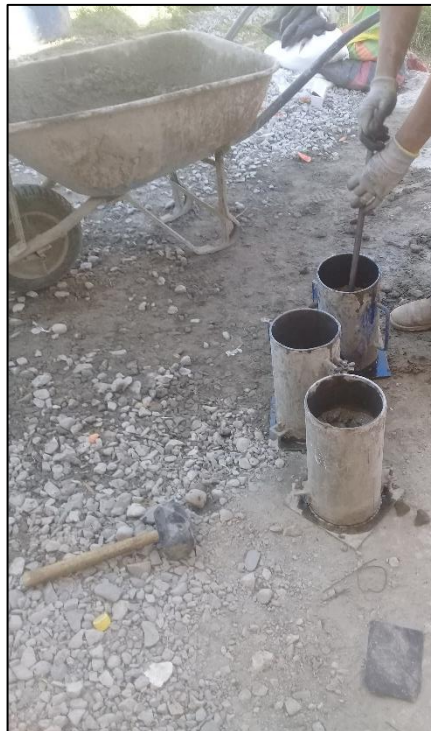
Fotografía N°07: Varillado de las probetas.
