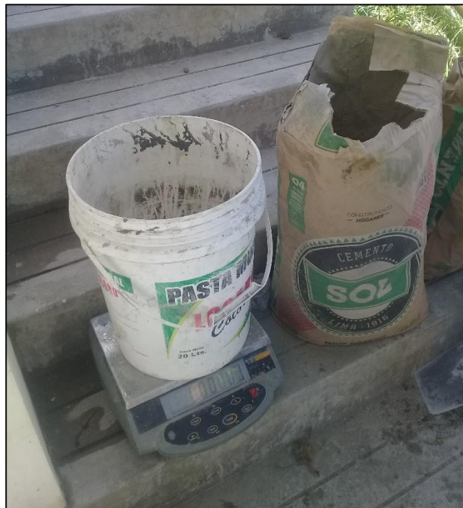
Fotografía N°03: Pesado del cemento según diseño de mezcla.
