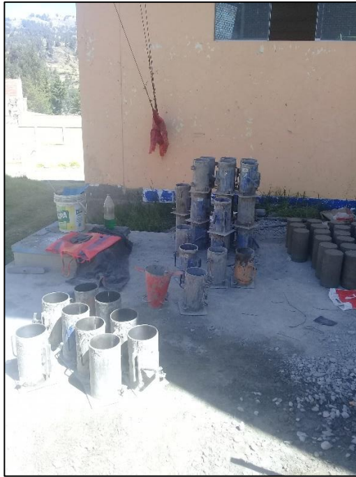
Fotografía N°02: Limpieza de moldes.
