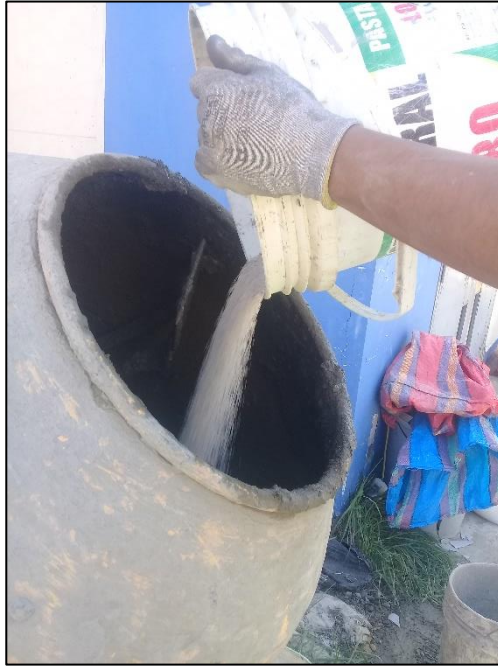
Fotografía N°06: Llenado del polvo de cuarzo a la mezcladora.
