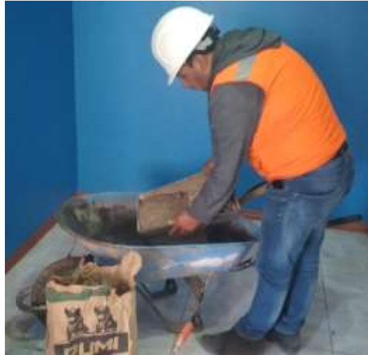
FOTOGRAFÍA N° 11: Mezcla del concreto
