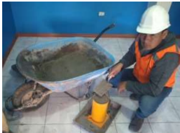
FOTOGRAFÍA N° 13: Colocación de la mezcla en el molde – 3ra capa
