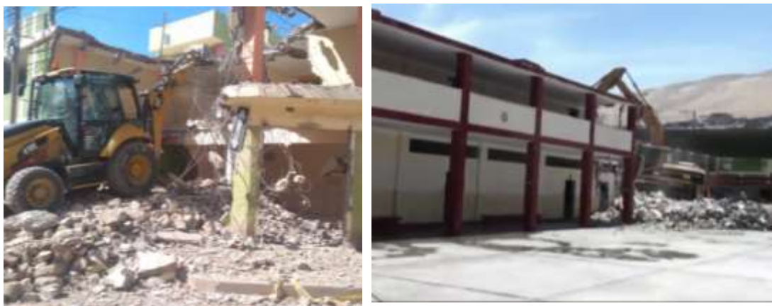
FOTOGRAFÍA N° 3: Demolición de la G.U.E. José Antonio Encinas
