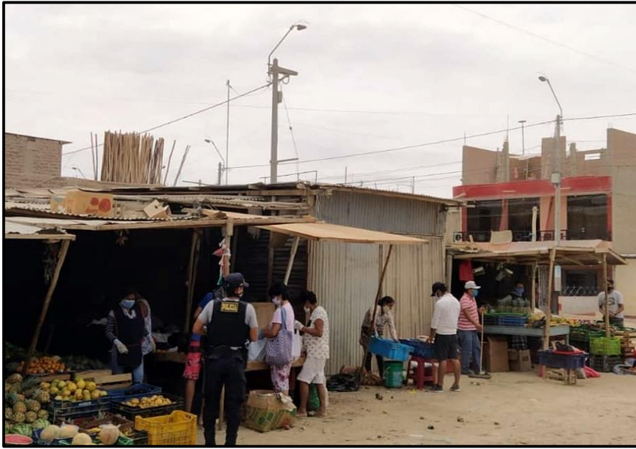
Figura 4. Infraestructura en malas condiciones.
