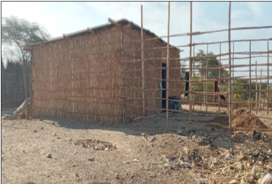
*Figura 8 Sistema constructivo con materiales tradicionales en viviendas en la zona rural.*
