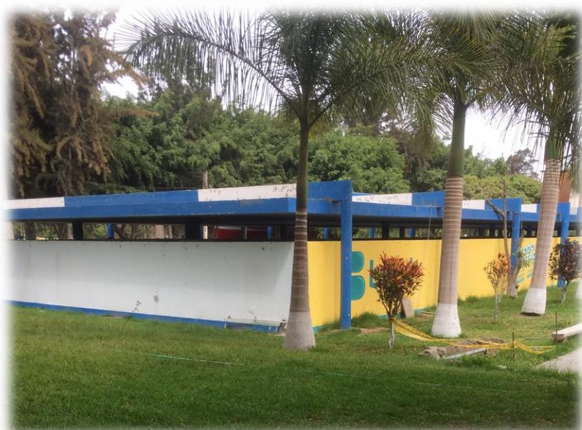
FIGURA N° 03: Servicios Higiénicos de lo Piscina
