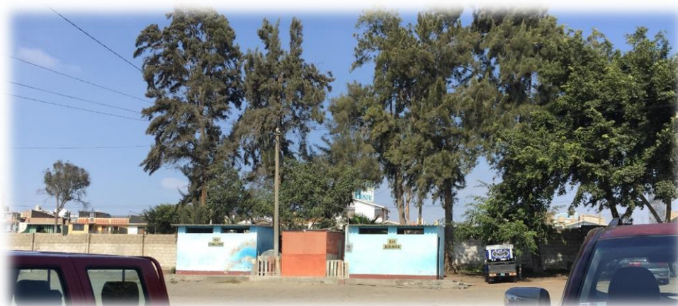
FIGURA N° 06: Servicios Higiénicos, del ingreso vehicular
