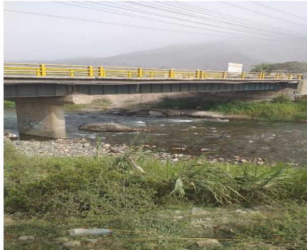
Figura 4. Estación E.CL2-Puente Quebrada Verde
