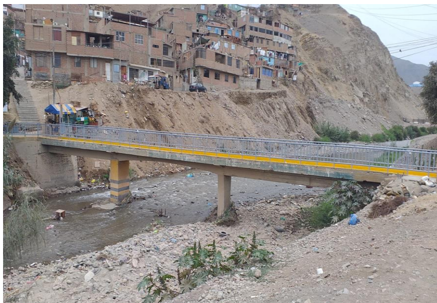
Figura 27. Estación E.CCH3-San Diego.
