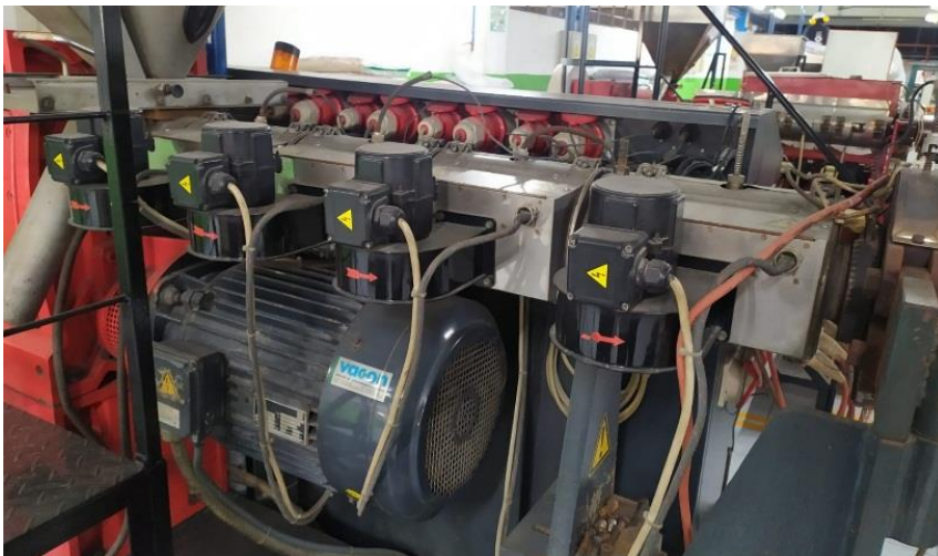
Figura 21. Montaje de los 4 ventiladores al motor. Fuente: elaboración propia.
