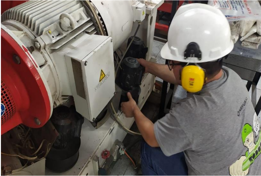
Figura 20. Desmontaje de ventiladores del motor. Fuente: elaboración propia.
