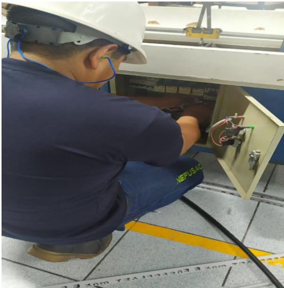
Figura 22. Limpieza de relays de 24 V DC. Fuente: elaboración propia.
