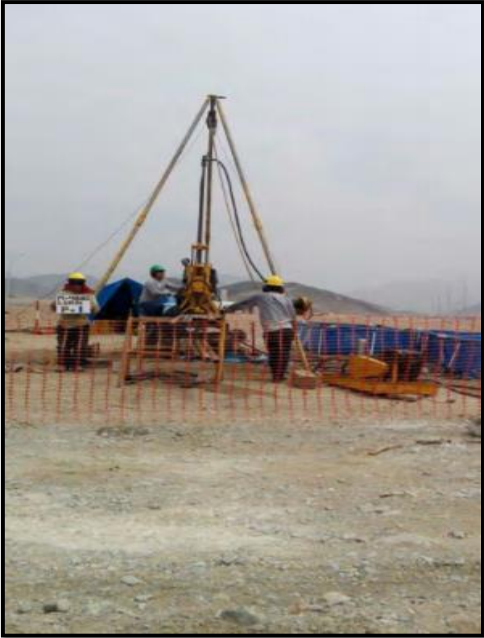
Figura 7. Foto de perforación rotativa P-1.
