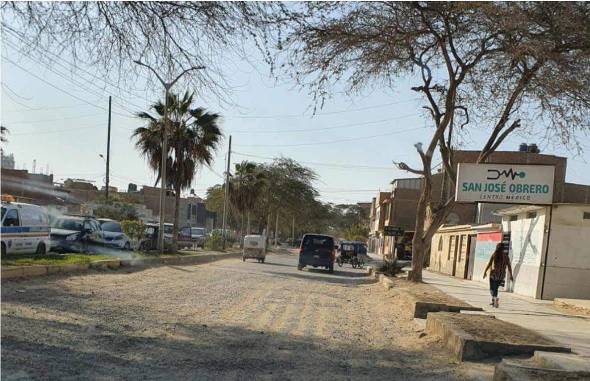
Figura 1. Estado actual de la Avenida Grau 1.
