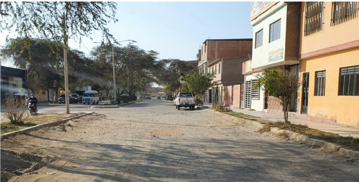
Figura 2. Estado Actual de la Avenida Grau 2
