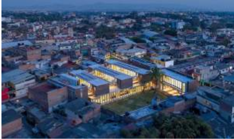
Figura 9: Vista aérea del Centro de Desarrollo Comunitario los Chocolates
