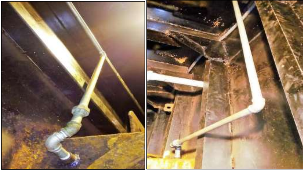
Figura 11 Tendido de línea de PVC
