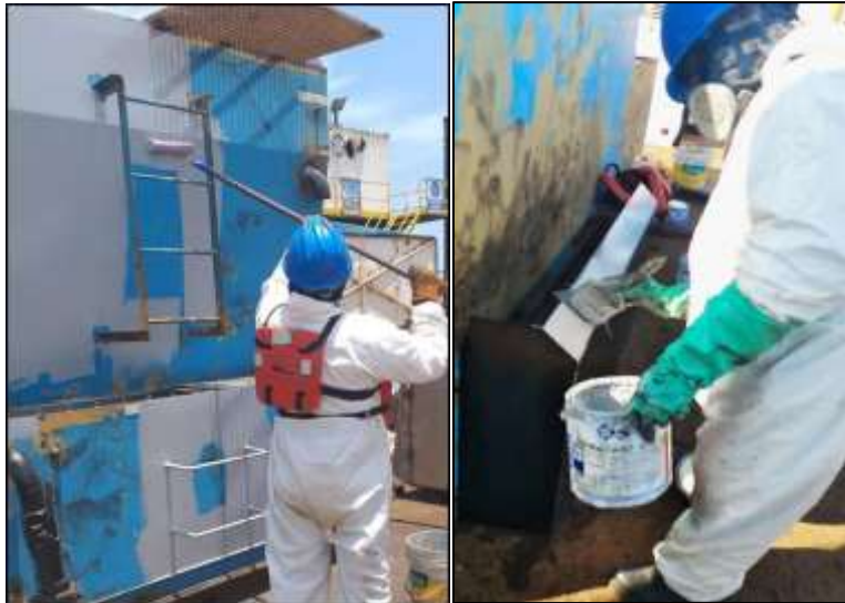
Figura 25 Pintado tricapa (4-4-2) de color gris (base) de las paredes externas de PTAR
