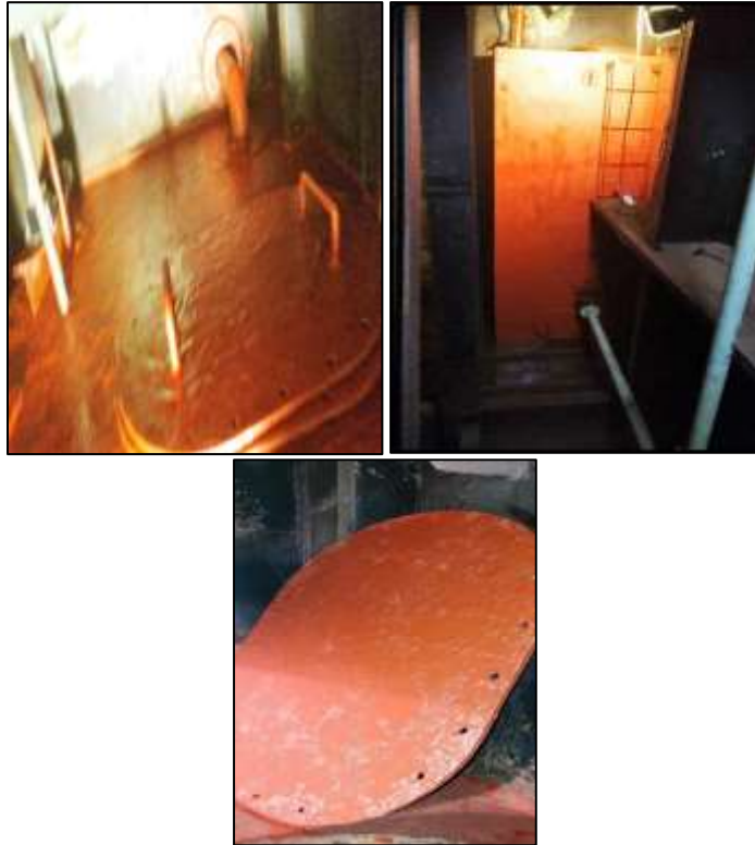
Figura 17 Pintado acabado exterior del tanque de aguas servidas
