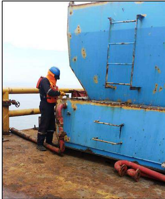
Figura 3 Personal contratista realiza la limpieza exterior de PTAR lado Proa
