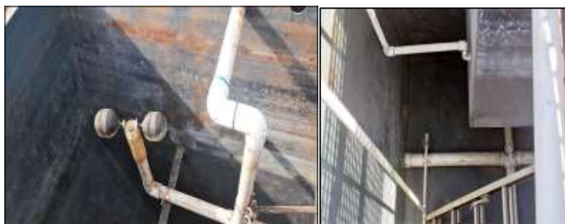
Figura 7 Limpieza interior de PTAR
