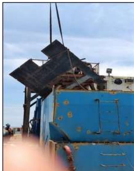
Figura 2 Desmontaje de tapa principal de PTAR con el apoyo de grúa
