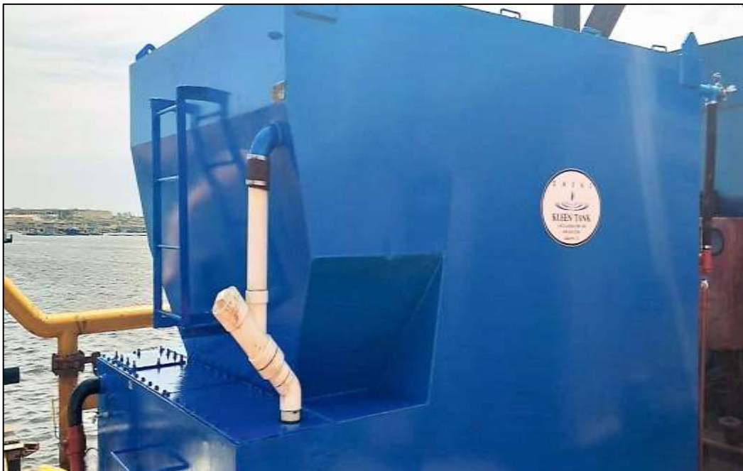
Figura 28 Mantenimiento de PTAR de Barcaza Oro finalizado
