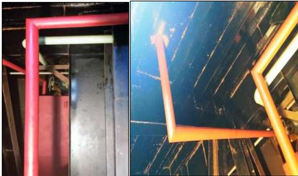
Figura 16 Estado posterior: Pintado acabado en color rojo de las líneas de PTAR
