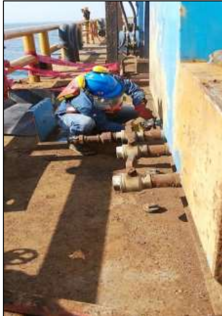
Figura 4 Personal contratista realiza la limpieza exterior de PTAR lado Babor
