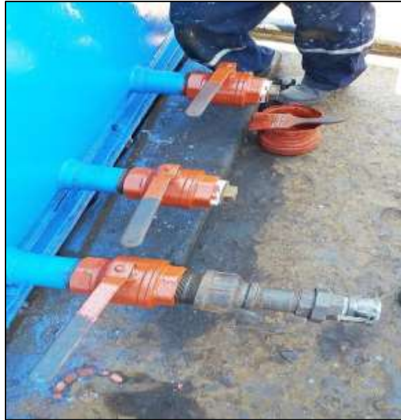
Figura 19 Pintado tricapa de válvulas de 3" para tanque de aguas servidas
