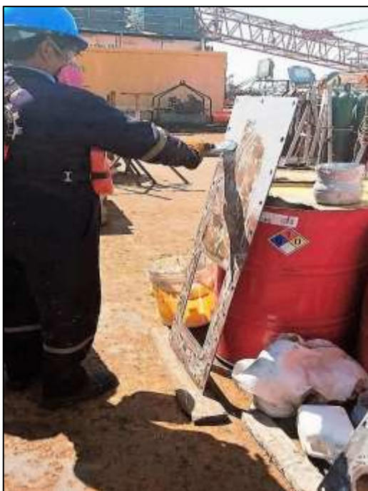
Figura 21 Estado intermedio: Pintado base en color negro de las tapas principales y auxiliares de PTAR (parte interna)
