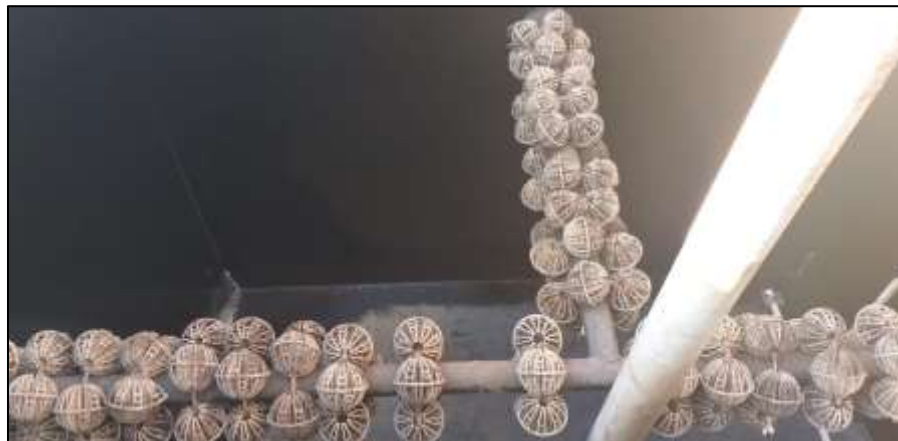
Figura 14 Estado intermedio: Pintado base en color negro de las paredes internas de PTAR
