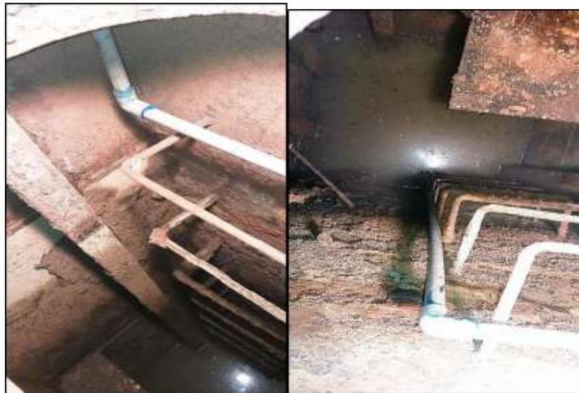
Figura 10 Tendido de línea galvanizada
