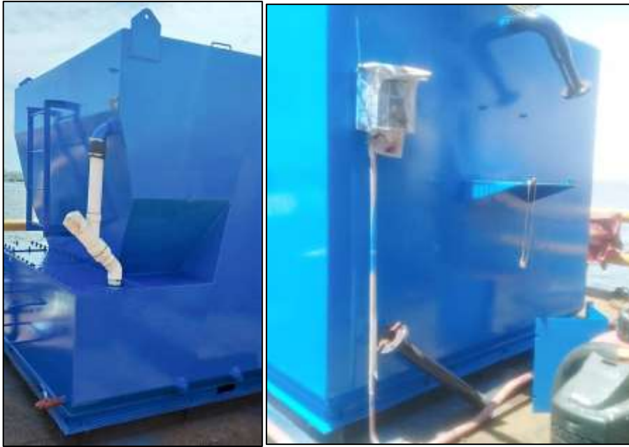
Figura 27 Estado posterior: Pintado acabado en color celeste oscuro de la zona externa de PTAR. Vistas popa y estribor respectivamente
