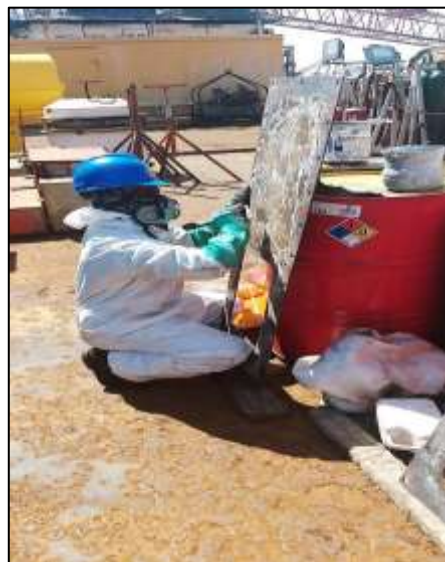
Figura 20 Limpieza metálica de tapas principales y auxiliares de PTAR
