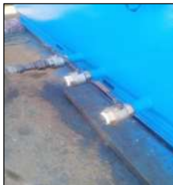
Figura 18 Limpieza metálica de válvulas de 3" de PTAR
