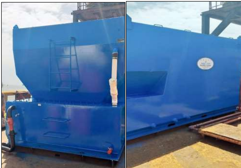
Figura 26 Estado posterior: Pintado acabado en color celeste oscuro de la zona externa de PTAR. Vistas proa y babor respectivamente
