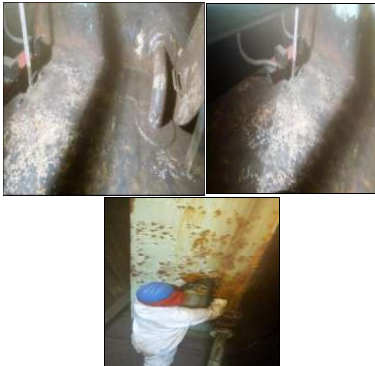
Figura 12 Limpieza manual y mecánica del tanque de PTAR (parte interna)
