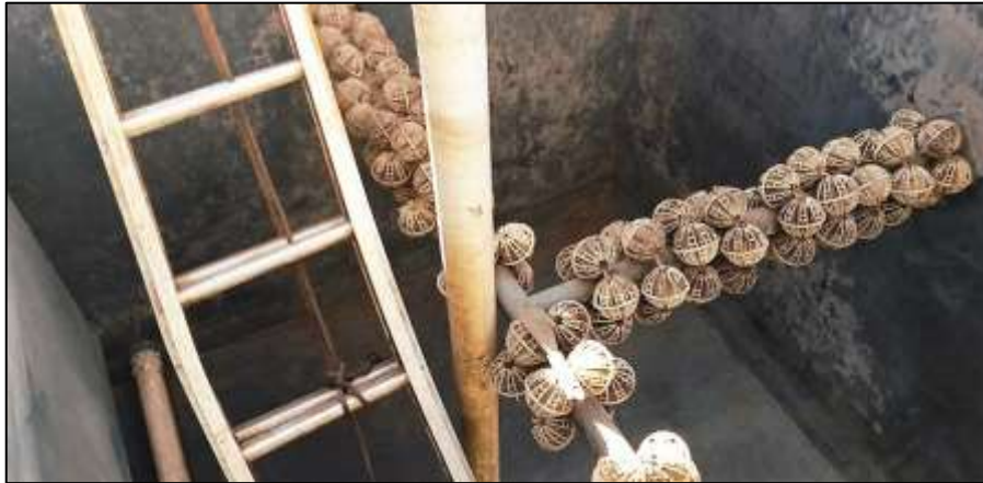
Figura 13 Estado anterior: Limpieza mecánica de las paredes internas de PTAR
