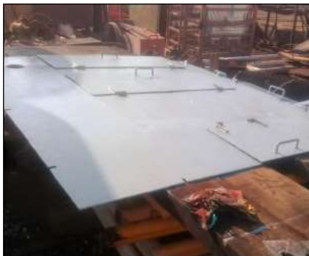
Figura 22 Estado intermedio: Pintado en color gris (2da capa 4-4-2) de las tapas principales y auxiliares de PTAR (parte externa)
