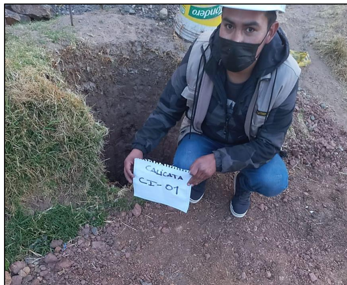
Figura 8. Excavación calicata C - 01. Fuente: Elaboración propia.
