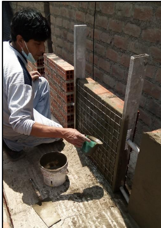
Figura 12. Proceso de lechado de murete antes de tarrajeo.
