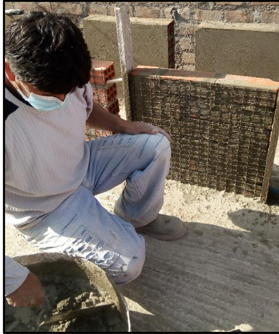
Figura 15. proceso de lechado y tarrajeo de muretes (M/G)
