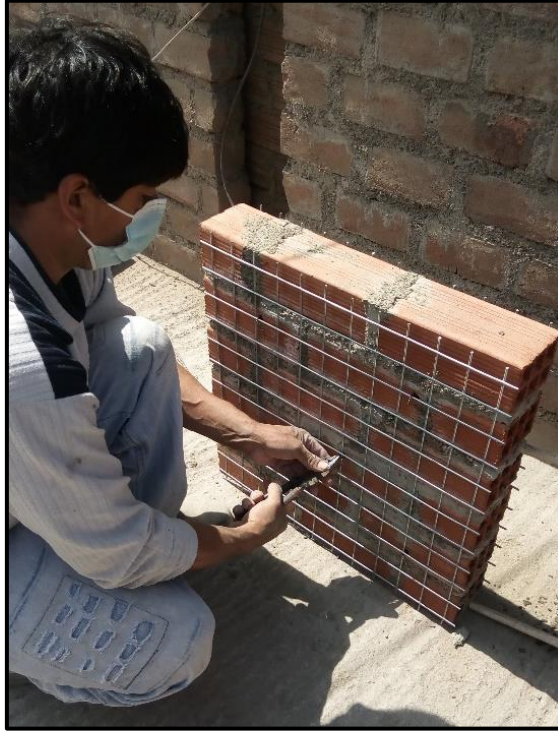
Figura 11. Proceso de anclaje de malla electrosoldada en el murete.
