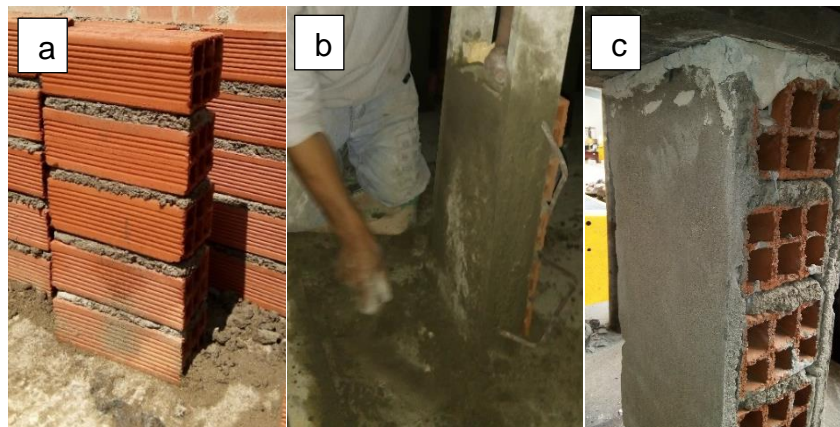
Figura 16. Proceso de construcción de pilas sin reforzamiento.
