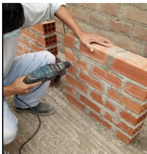
Figura 10. Realización de orificio para anclaje de malla electrosoldada.
