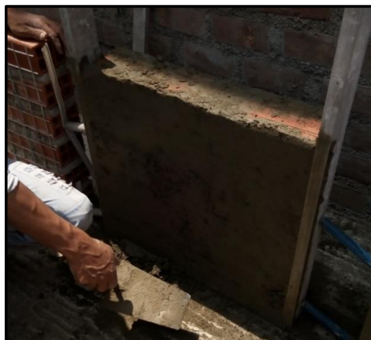
Figura 8. Proceso de tarrajeo de muretes patrón sin reforzamiento.
