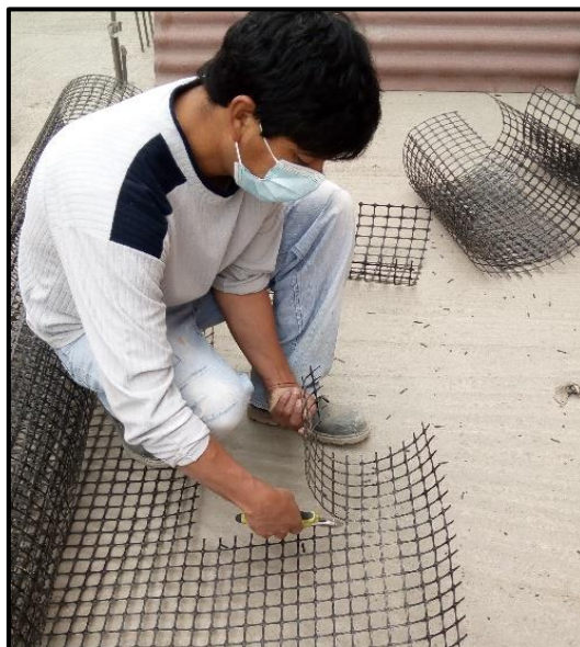
Figura 14. Acondicionamiento de geomalla al murete (M/G)
