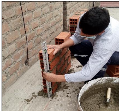
Figura 9. Sentado de ladrillo en la construcción de murete reforzado con malla electrosoldada.
