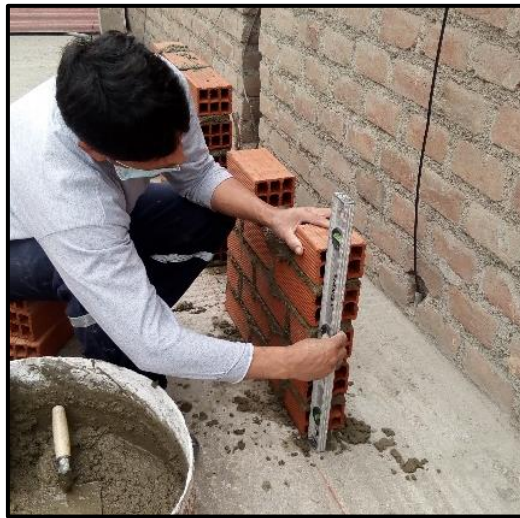
Figura 7. Sentado de ladrillo en la construcción de murete patrón
