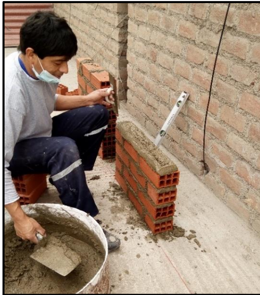
Figura 13. Sentado de ladrillo en la construcción de murete reforzado con geomalla.
