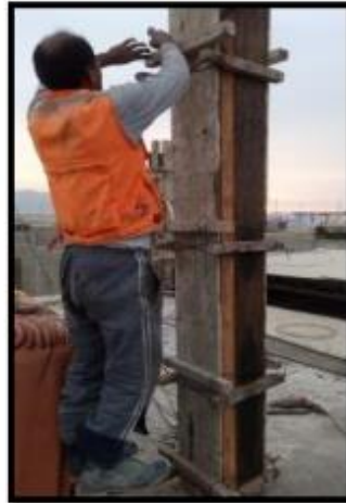
Img.06.29: Colocación del alambre N°8 y N°16
