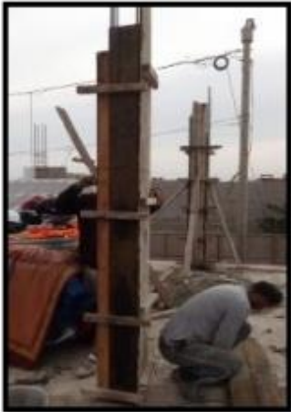
Img.06.28: Armado del encofrado
