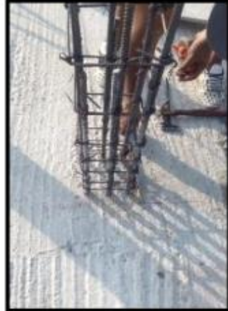
Img.06.27: Trazo para escuadrar encofrado
