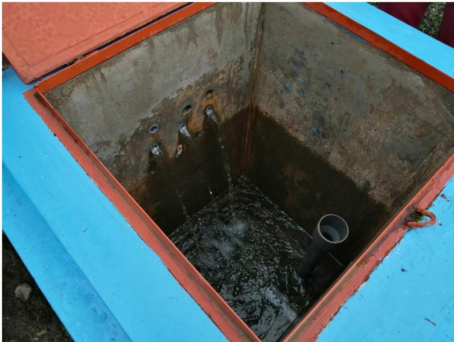
*Figura 32.* Estructura de captación del manante Chaccamarca
