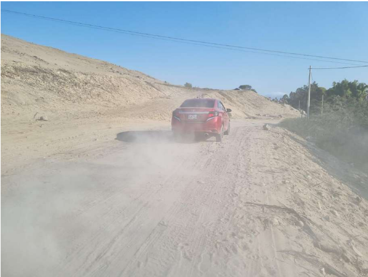
Imagen N° 09: Presencia de polvo en progresiva 2+171.80 al 2+218.00
