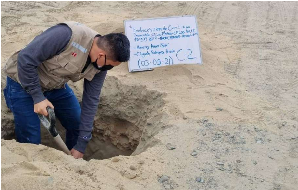
Imagen N° 21: Recolección de muestra de calicata N°2
