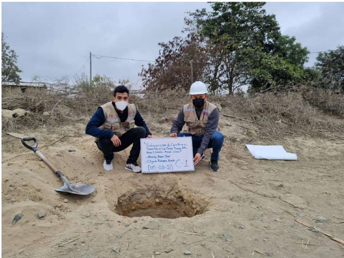
Imagen N° 20: Recolección de muestra de calicata N°1
