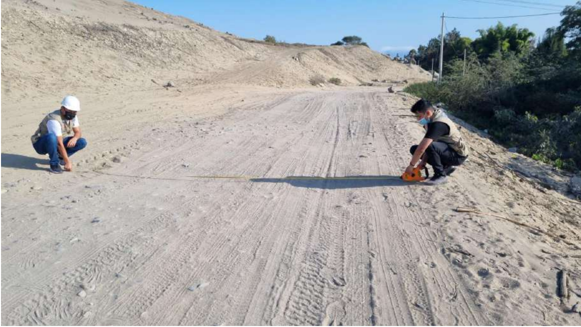
Imagen N° 08: Medición de ancho de calzada en progresiva 2+171.80 al 2+218.00
