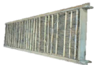
Panel entramado de cañabrava con barro y paja
