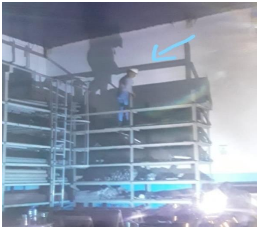
Figura 6: Se evidencia que el oficial no utiliza arnés de seguridad en la descarga del material en el anaquel.
