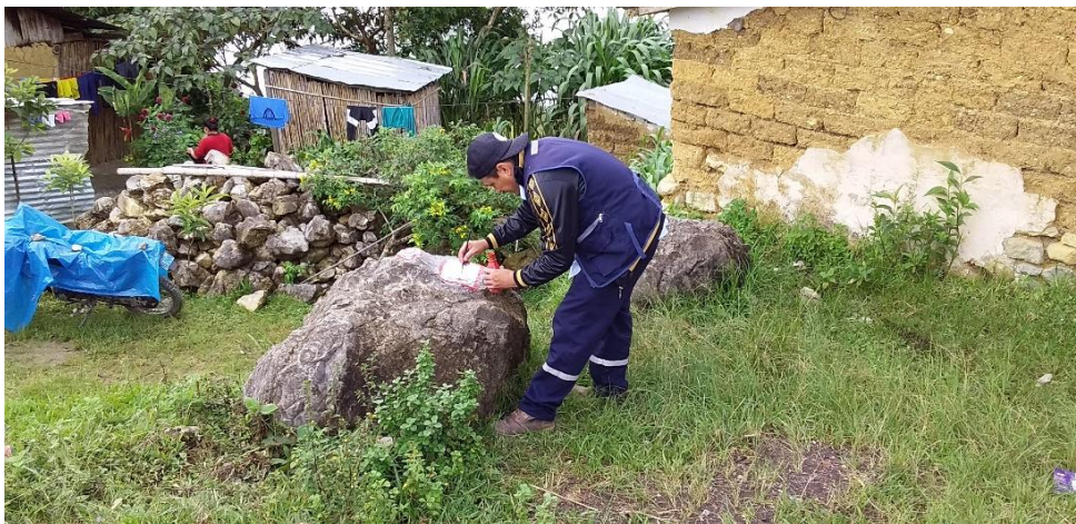
Fotografía N°04: Puntos Fijos (BM) para realizar el estudio Topográfico.
