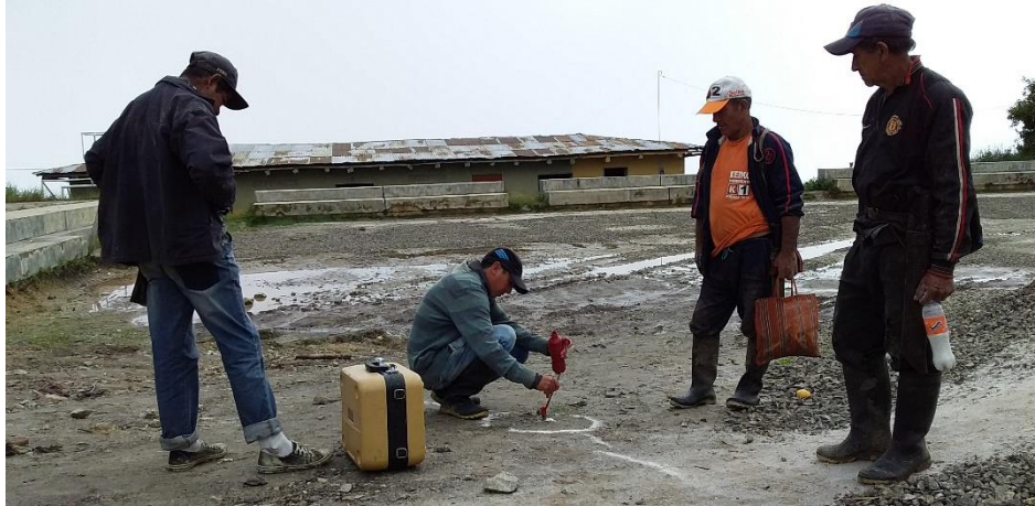
Fotografía N°03: Puntos Fijos para realizar el estudio Topográfico.
