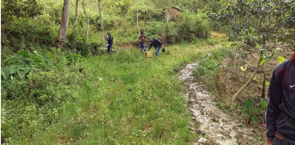
Fotografía N°06: Realizando el levantamiento topográfico de la carretera en estudio.
