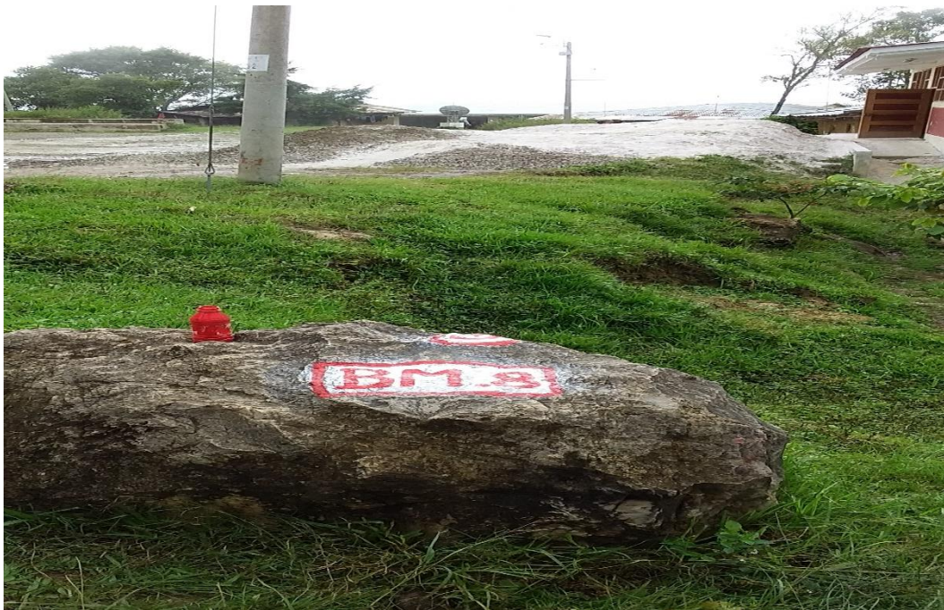
Fotografía N°04: Pintado de BM's en el campo.
