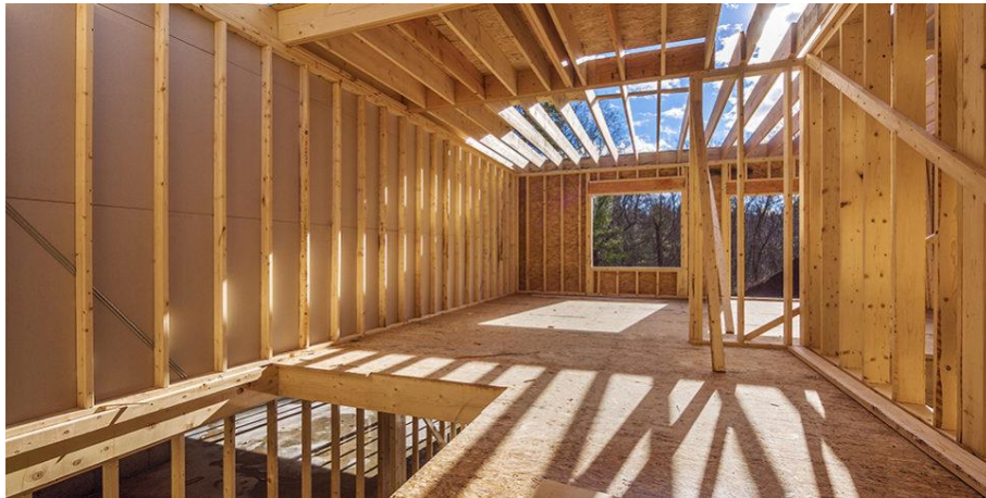
Figura N° 3: Sistema estructural de Entramados
