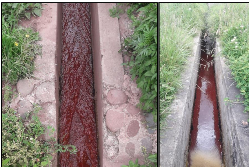
Figura 10 Canal de las aguas del Camal Municipal.
