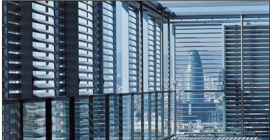
Figura 32. Sistema de celosías
