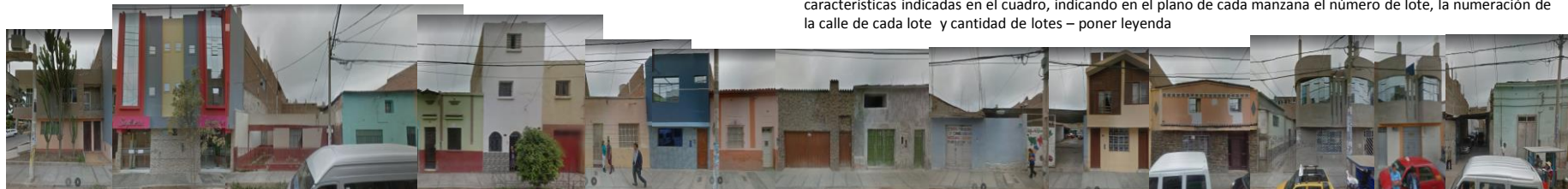
P.24-b.) Tira de imágenes de toda la urbanización desarrollada por manzanas. (la numeración de las manzanas y los lotes se han sacado de la base catastral de la MPCH)
