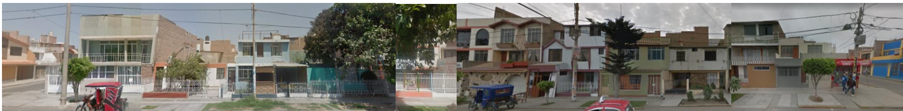
P.24-b.) Tira de imágenes de toda la urbanización desarrollada por manzanas. (la numeración de las manzanas y los lotes se han sacado de la base catastral de la MPCH)
