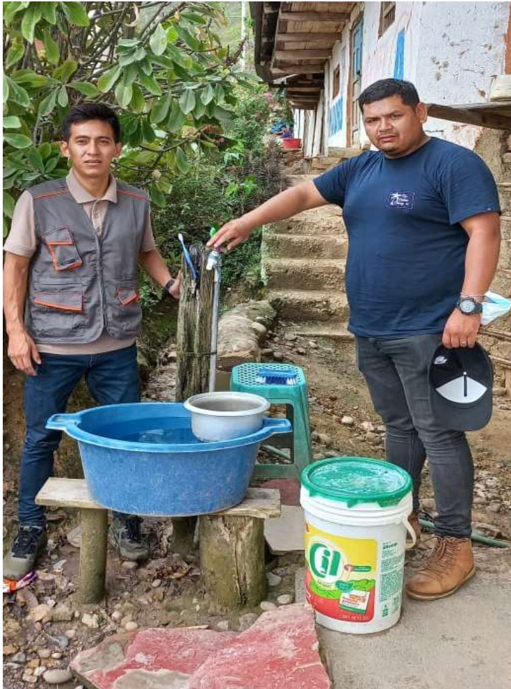
Ilustración 4: Medición de Caudal de una conexión domiciliaria.
