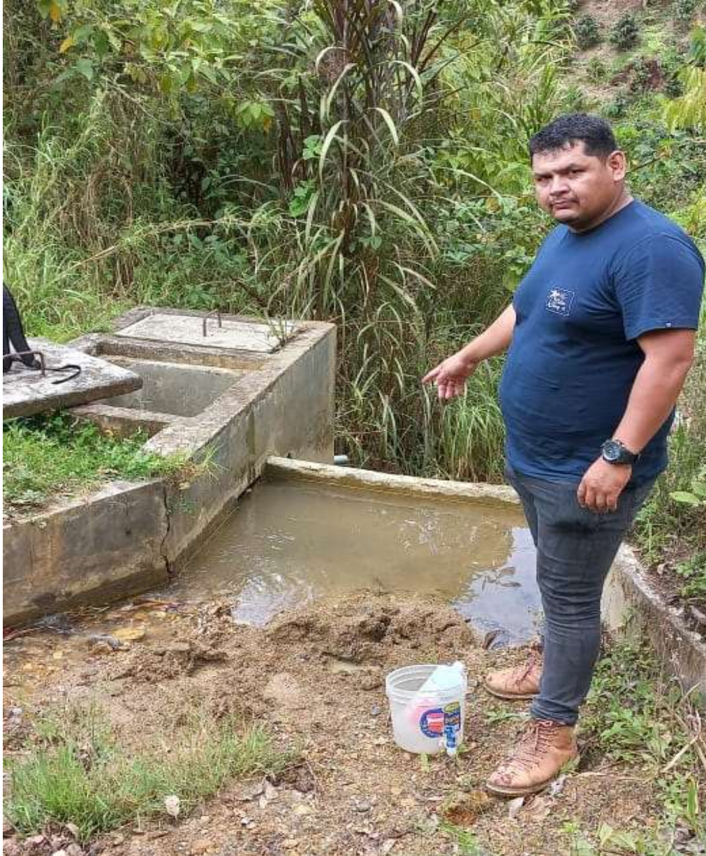
Ilustración 3: Captación y Reservorio existente.
