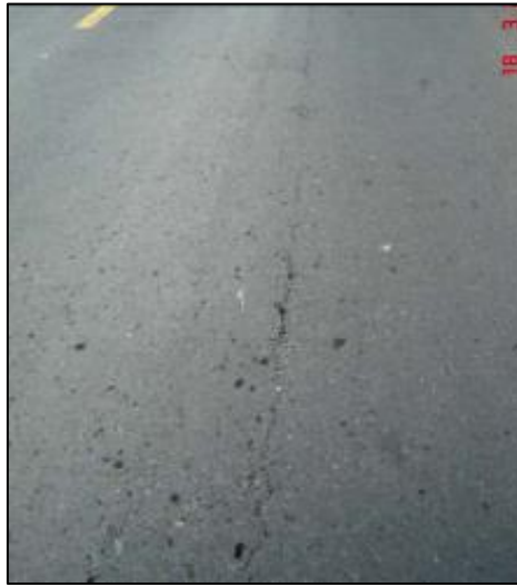
Figura 9. Fisura Longitudinal
