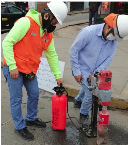
Fotografía 57. Extracción de testigo 2
