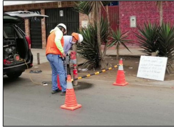
Figura 39. Extracción del 3er testigo Fuente: elaboración propia
