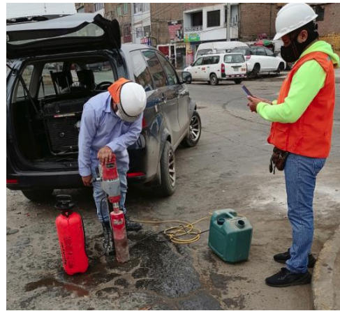
Fotografía 56. Extracción de testigo 1
