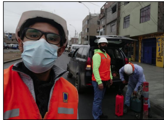
Figura 41. Extracción del testigo 4 Fuente: elaboración propia
