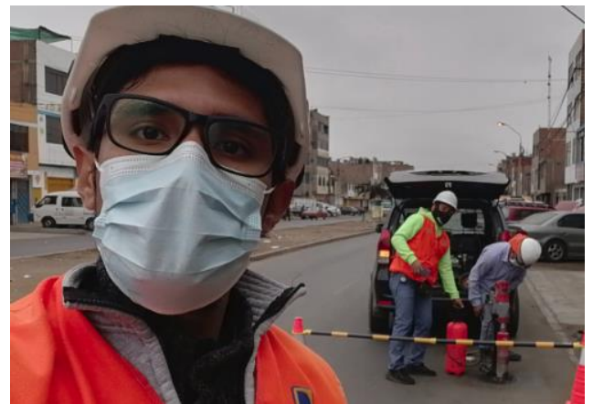
Fotografía 58. Extracción de testigo 3
