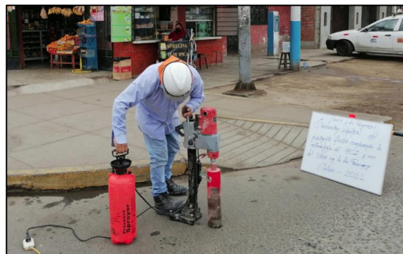
Figura 37. Bombeo para la extracción del Testigo 2
