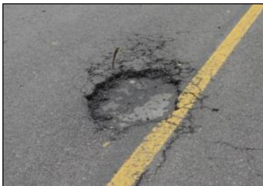
Figura 14. Descascaramiento
