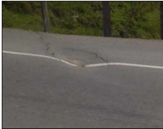
Figura 5. Hundimiento
