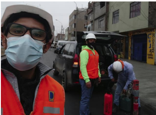
Fotografía 59. Extracción de testigo 4
